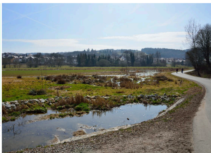
Abb. 54 Umleitung des gesammelten Niederschlagswassers
