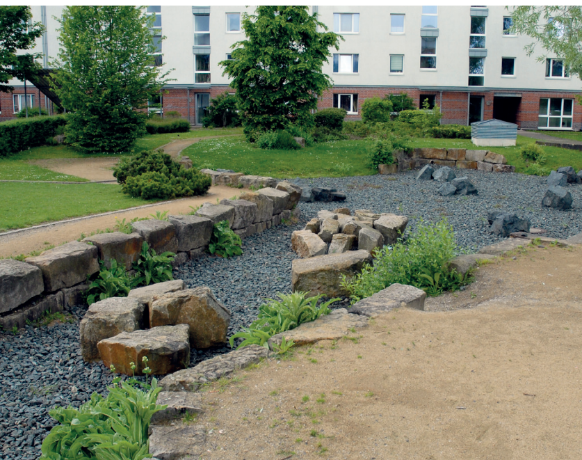
Abb. 11 Regenrückhaltefläche in einem Blockinnenhof
