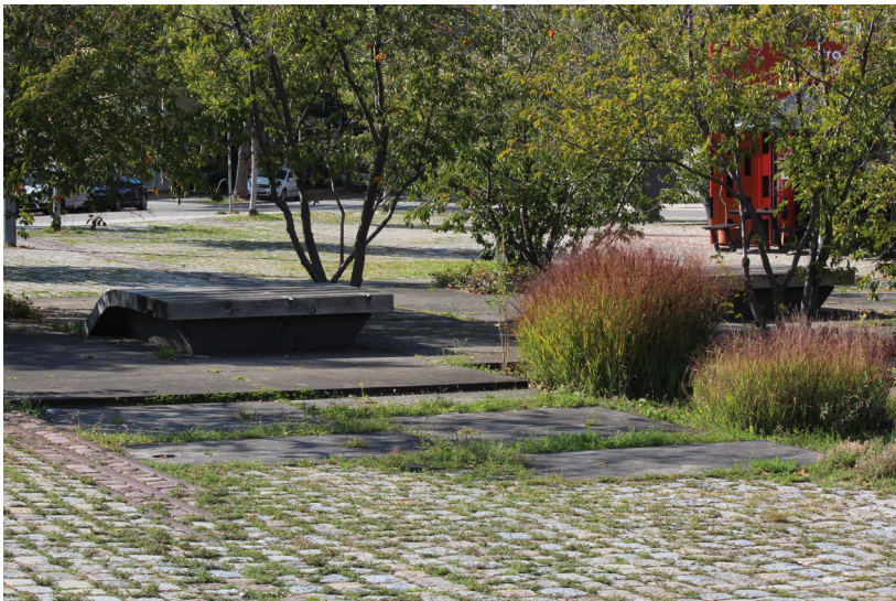
••• Abb. 59 Niederschlagswasser fließt von befestigter Fläche (rechts im Bild) in Versickerungsbeete (unten)
