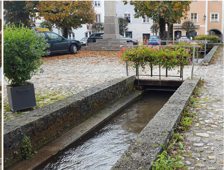
Abb. 37 Reaktivierung Dorfbach bei beengten Verhältnissen
