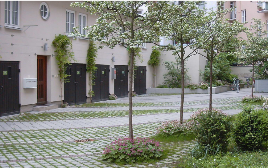
Abb. 15 Durchlässige Beläge in einem Innenhof
