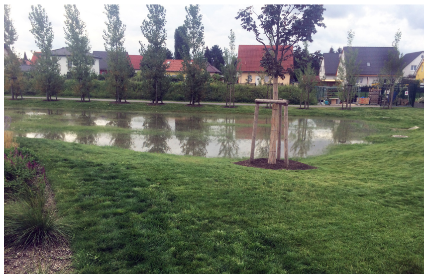
Abb. 43 Zentrale Regenrückhaltefläche in einem Wohngebiet
