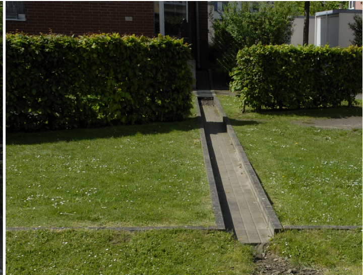
Abb. 27 Sammelrinne zur Ableitung auf Rasenfläche
