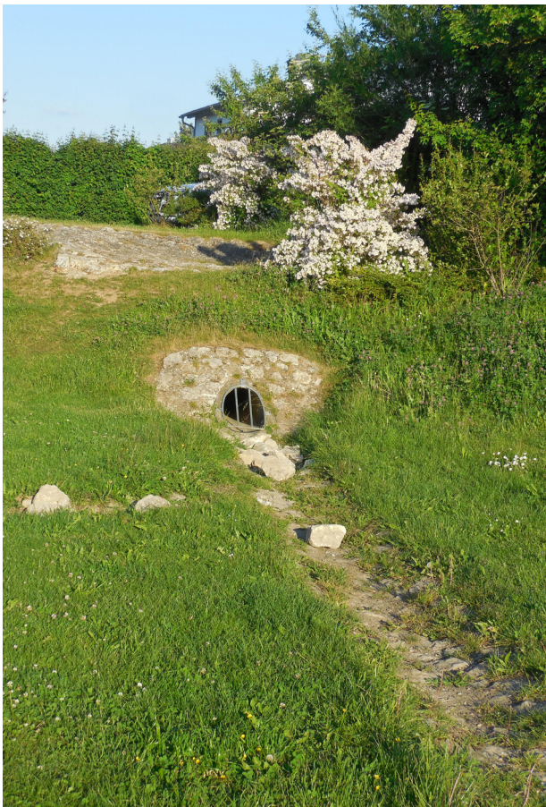
Abb. 46 Zulauf des Regenwassers
