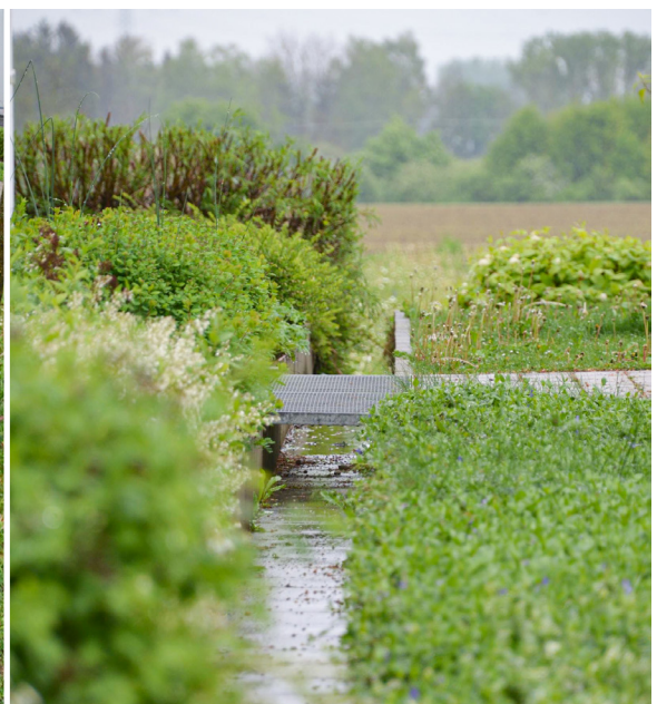
••• Abb. 45 Offene Ableitung von Niederschlagswasser
