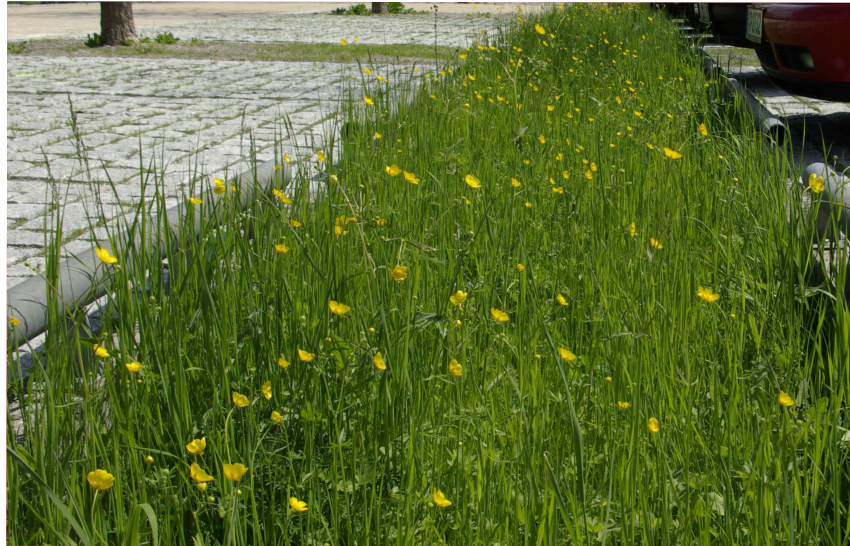
Abb. 24 Rasenpflaster und Muldenversickerung
