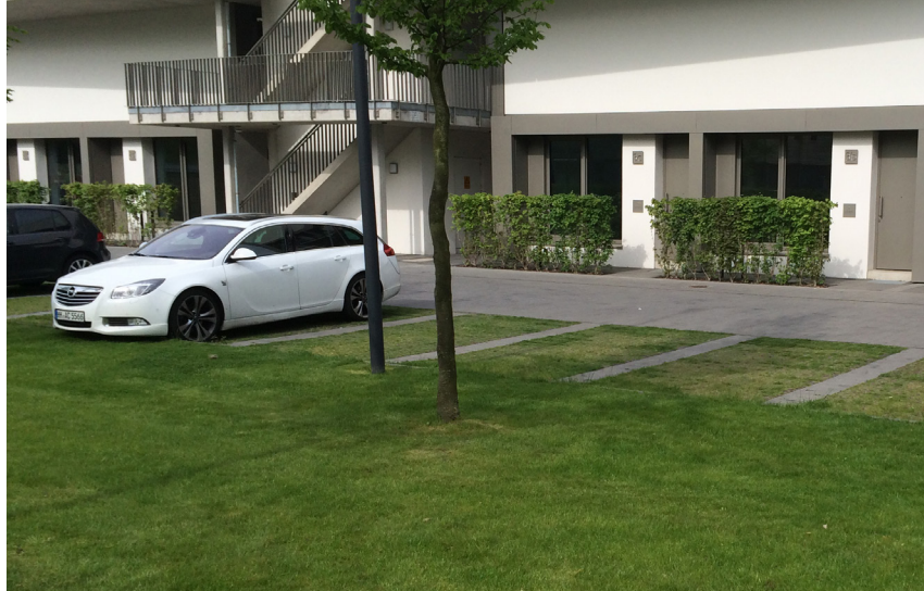
Abb. 17 Durchlässiger Belag mit Vegetationsanteil
