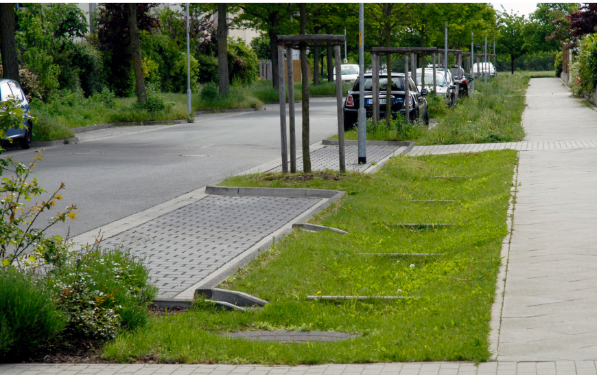
Abb. 22 Muldenkaskaden zur Versickerung von Straßenabflüssen
