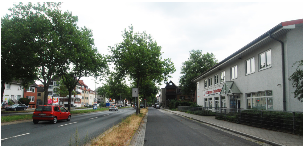
❖ Abb. 28 Ist-Zustand: Die Verkehrsfläche ist stark versiegelt. Im Falle eines Starkregens kann es zu unkontrollierten Abflüssen des Wassers und Überflutungen kommen. Dies kann Schäden an den angrenzenden Gebäuden hervorrufen.
