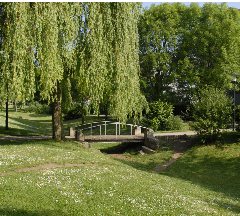
Abb. 41 Zentrale Regenwassermulde in einem Wohngebiet
