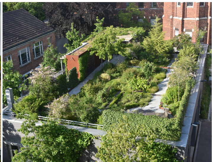
Abb. 19 Intensives Gründach auf einem Verwaltungsgebäude
