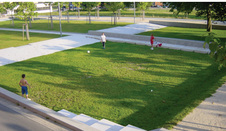
Abb. 13 Erholungsfläche mit temporärer Rückhaltefunktion
