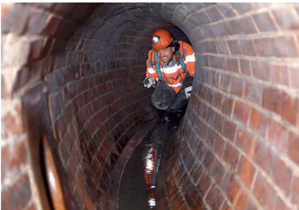
Die Kontrolle des Zustandes von Sammelkanälen mit Eiquerschnitt erfolgt durch eine Begehung.
