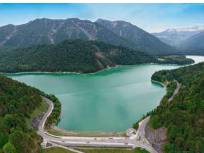
Blick über den Damm des Sylvensteinspeichers
