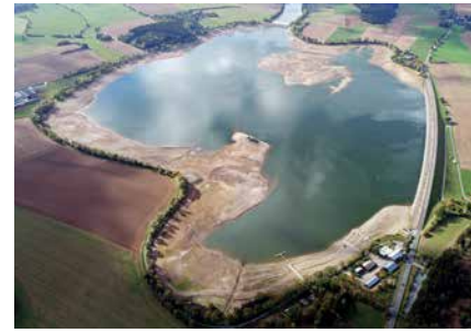
Die Förmitztalsperre mit trockenen Uferbereichen im September 2018
