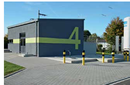
Anlage zur Spurenstoffelimination an der Kläranlage Weißenburg
