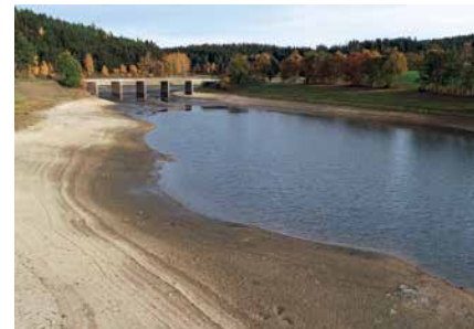
Der stark beanspruchte Liebensteinspeicher bei Tirschenreuth: 70 % des Betriebsraumes wurden zur Niedrigwasseraufhöhung der Tirschenreuther Waldnaab genutzt.
