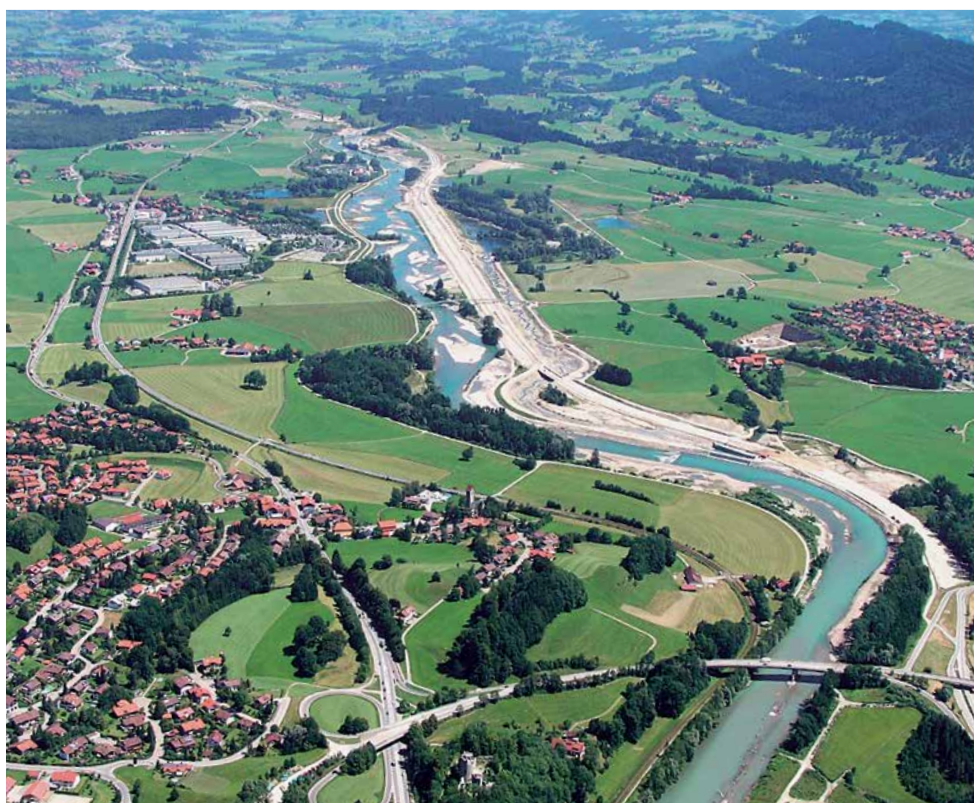
Flutpolder wie hier der Polder Weidachwiesen an der Iller (Landkreis Oberallgäu) sind eingedeichte Senken oder Flussniederungen, die bei größeren Hochwasserereignissen gezielt geflutet werden, um die Abflussspitzen im Fluss abzusinken.
