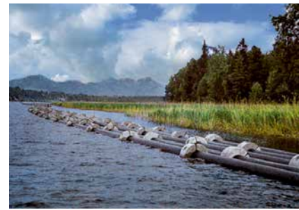
Zwischenlagerung der verlegefertigen Rohre für die Chiemsee-Ringkanalisation
