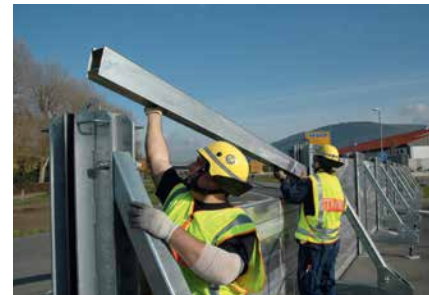
Probeaufbau der mobilen Hochwasserschutzzelemente in Miltenberg
