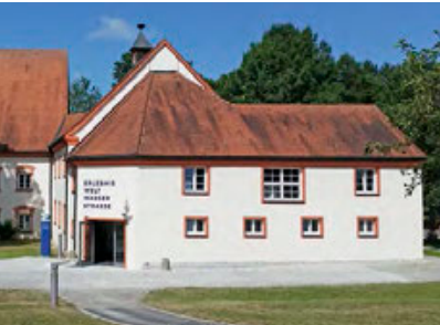
Die Revierzentrale Gösselthal der Wasserstraßen- und Schifffahrtsverwaltung des Bundes
