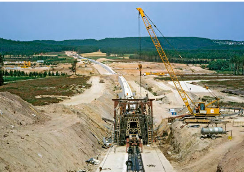
Nach dem Abdichten des Untergrunds begann der Bau des 1,6 km langen Kontrollgangs.
