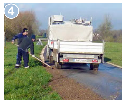
Von oben nach unten zur Verkehrssicherung:
