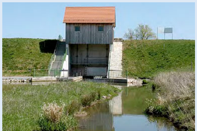
Der Betriebsauslass mit Fischpass am Hochwasserrückhaltebecken Burghaslach
