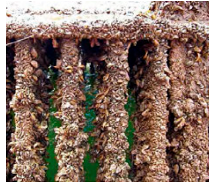
Rechts oben: Völlig mit Muscheln besetzter Rechenkorb eines Entnahmeturmes am Brombachseedamm
