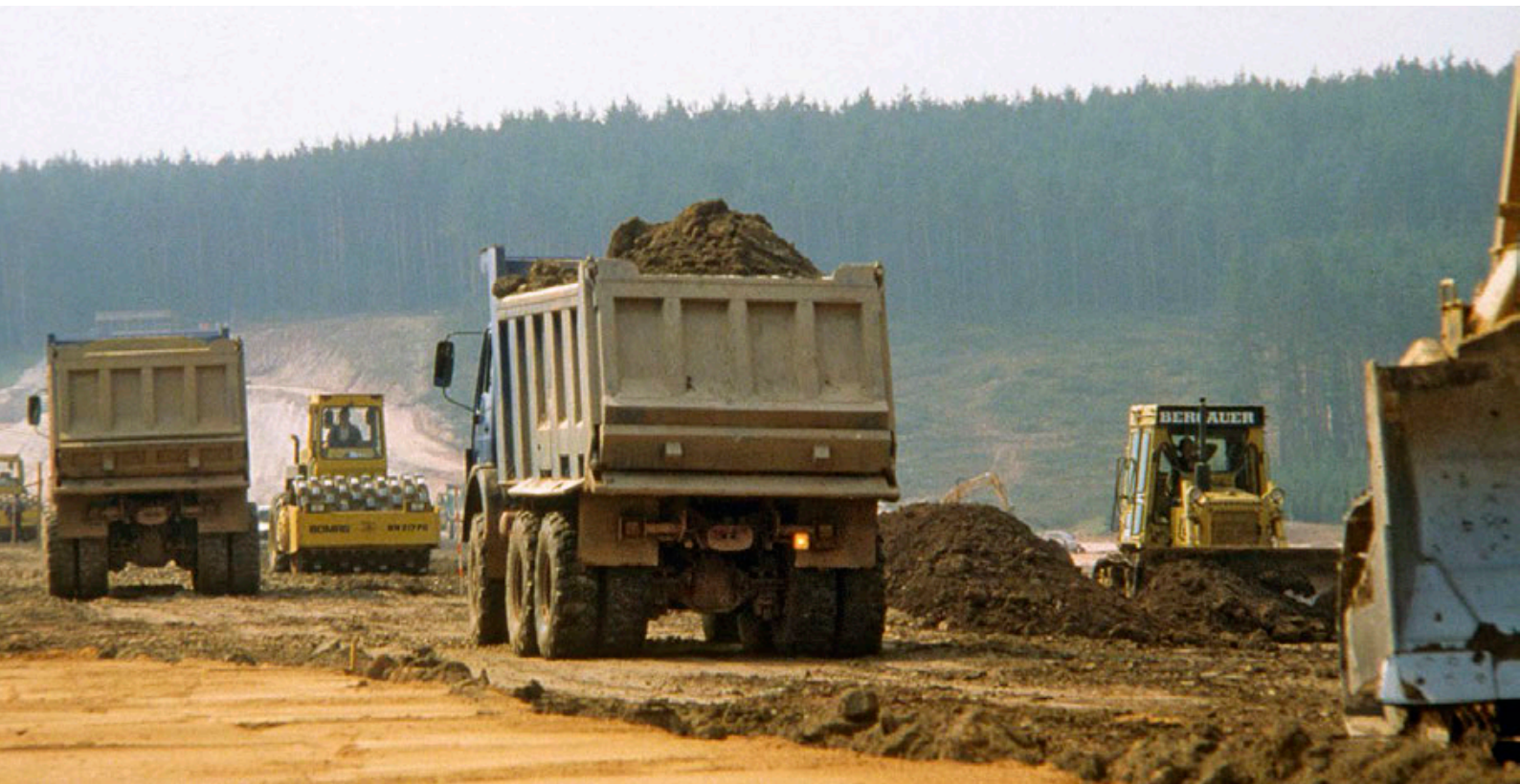
Dammschüttung am Großen Brombachsee in vollem Gange
