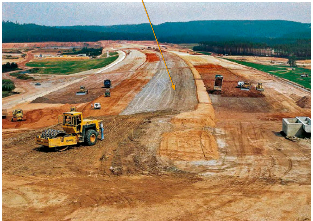
Der zonenweise Aufbau der Brombach-Hauptsperrdeiche spiegelt sich in den unterschiedlichen Farben des Schüttmaterials wider. Insgesamt wurden rund 4 Mio. m 3 Erdmaterial eingebaut.
