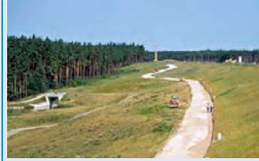
29.07.1992 Einstaubeginn Rothsee-Haupt- sperre
