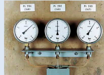
Oben: Manometer zeigen den Wasserdruck im Innern des Dammkörpers an. Oben links: Ein Mitarbeiter des Wasserwirtschaftsamtes kontrolliert den Wasserdruck im Kontrollgang des Dammes. Mitte: Die Sickerwassermessstelle am tiefsten Punkt des Kontrollganges erfasst das gesamte Wasser des Filters hinter dem Dichtungskern.
