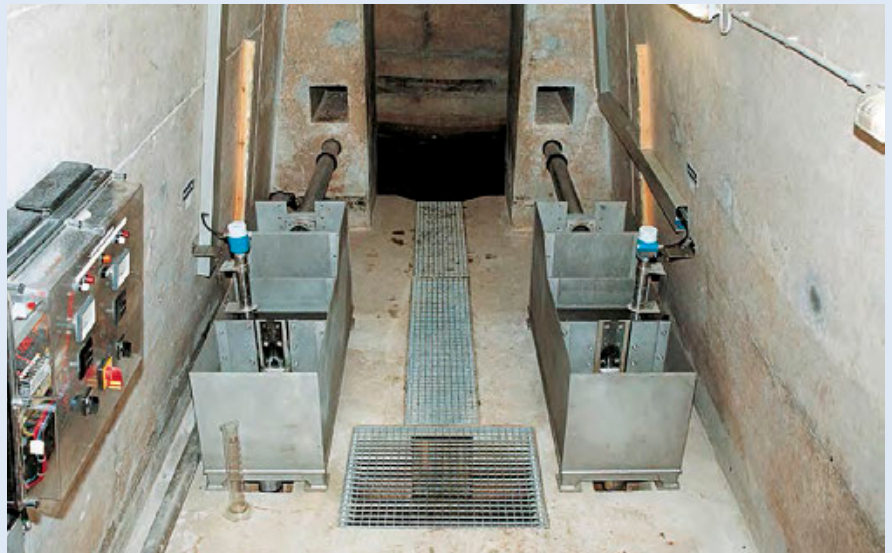
Unten: Dammschnitt mit Messeinrichtungen am Großen Brombachsee
