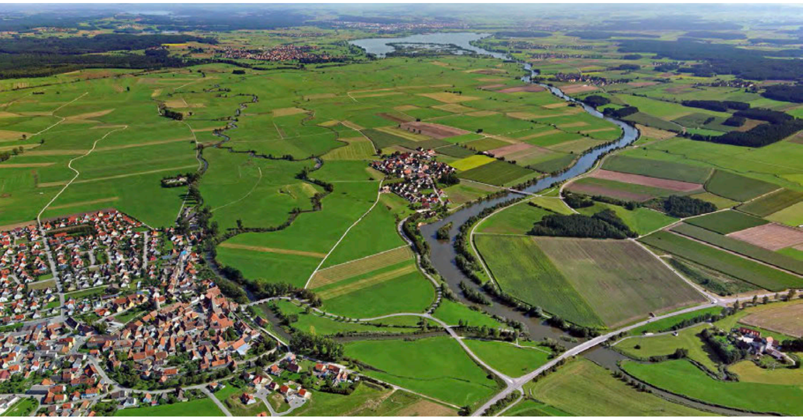
Nahе des Städtchens Ornbaу beginnt die Brombachüberleitung mit der Zuleitung zum Altmühlsee. Die mäandrierende Altmühl (links) umfließt den Altmühlsee in einem neu geschaffenen Flussbett.
