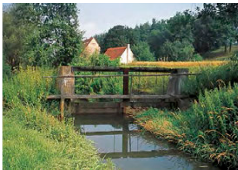
Das alte Wehr Heinzenmühle
