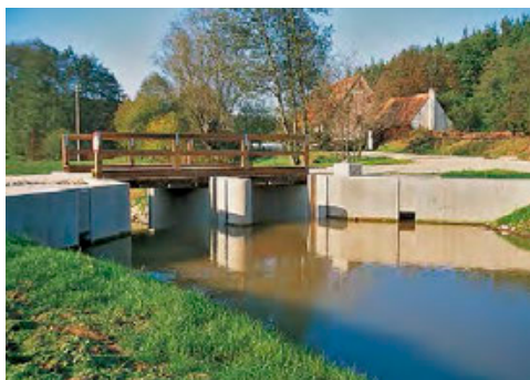
Das Wehr Heinzenmühle kurz nach der Fertigstellung
