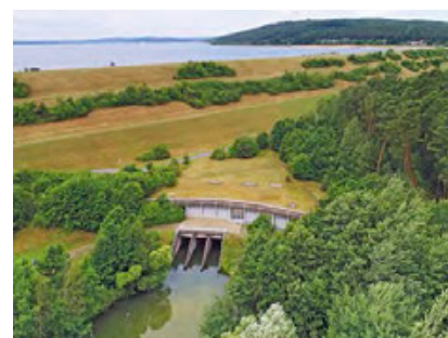
Der Damm des Großen Brombachsees ist ein präzise überwacht Bauwerk, im Vordergrund das Krafthaus.
