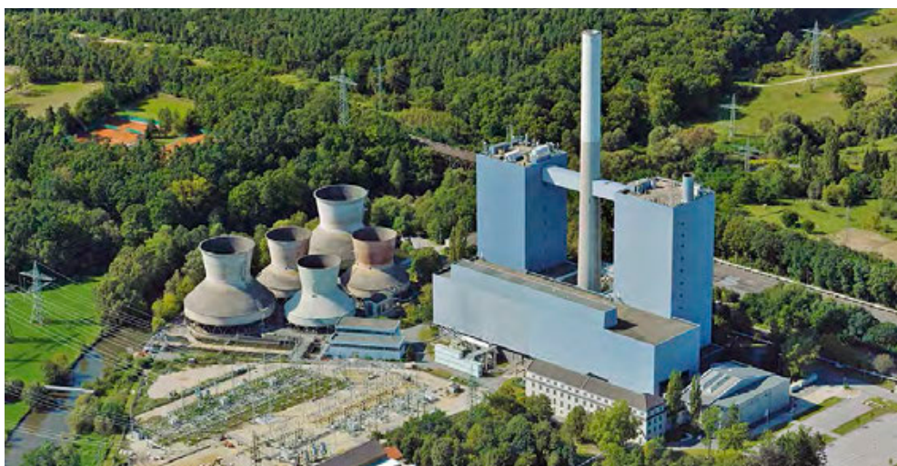
Das letzte noch in Betrieb befindliche Kraftwerk Nürnberg-Gebersdorf
