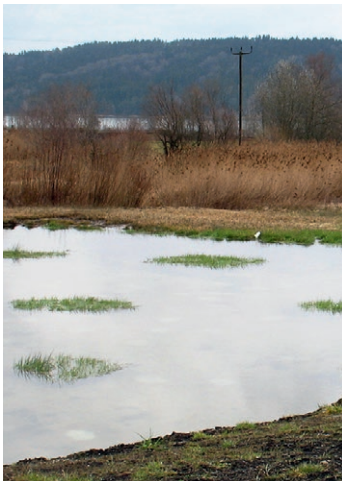
Rückhaltebecken kurz nach der Fertigstellung (unten) und mit ersten Pflanzen bewachsen (oben)
