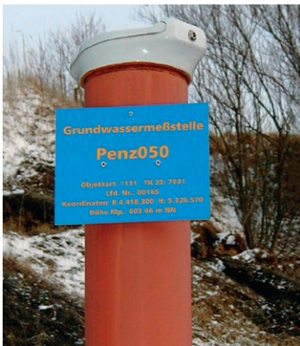
Grundwassermessstelle in Penzing bei Landsberg am Lech
