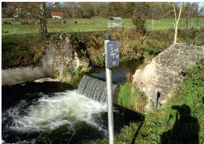
An der Attel wurde ein Seitenarm angelegt (rechts). Wasserlebewesen können so den Absturz (links) umgehen.
