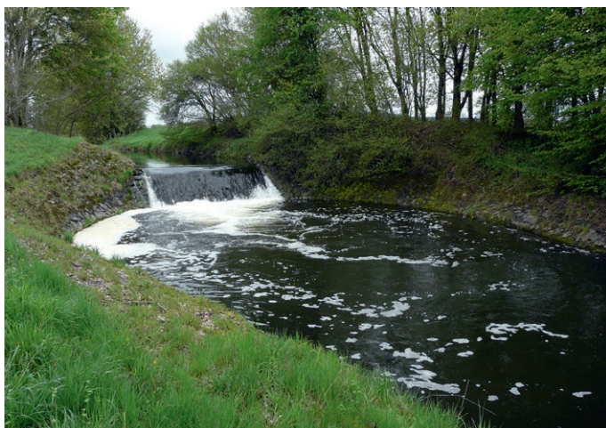
Umbau eines Absturzes an der Mindel: vor (links) und nach der Maßnahme
