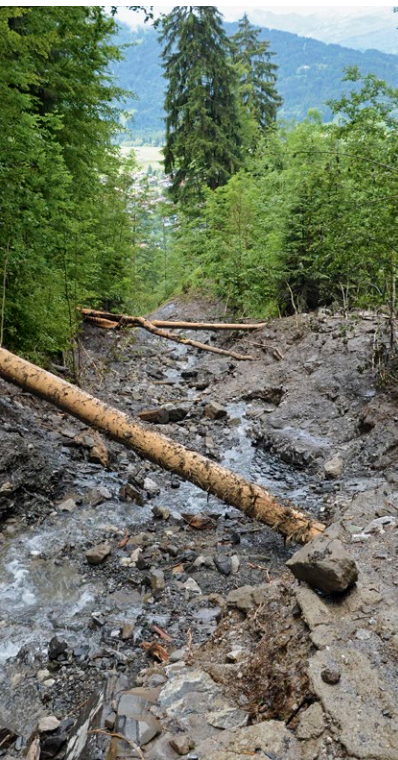
Bei einem Extremereignis wurde dieser Bachlauf durch einen Murgang „ausgeräumt“ (Rossbichlbach, Oberstdorf).
