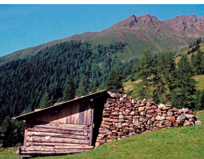
Unten: Spaltkeile teilen die Lawine auf, damit sie am Gebäude vorbei gelenkt wird (Südtirol).
