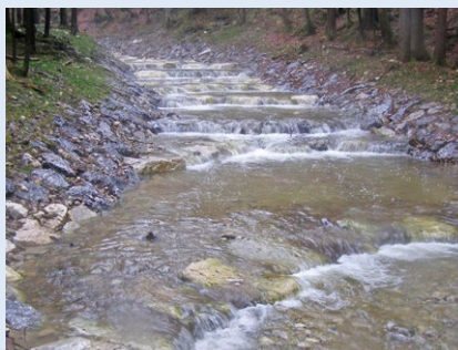
Uferverbau und Sohlswellen
