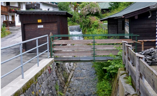
Extrem beengte Platzverhältnisse: glattes „Schussgerinne“ nötig
