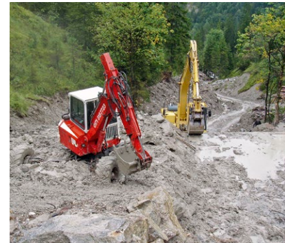
Links: Historische Bauverfahren Rechts: Schreitbagger in schlecht zugänglichem Gelände (Lainbach, Bendediktbeuern)
