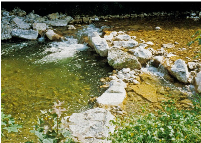
Links: Aufgelöste Schwellen zur ökologischen Durchgängigkeit (Auerbach, Oberaudorf)
