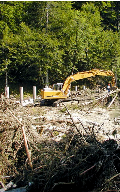
Rückhaltebauwerke müssen regelmäßig geräumt werden, nur so können sie die Funktion wieder erfüllen.
