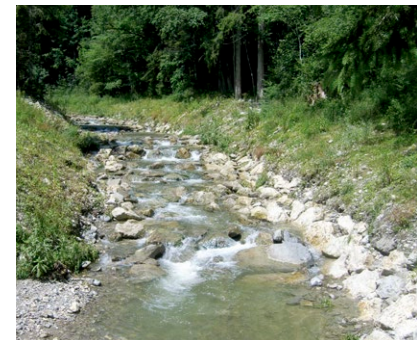
Umbau einer Sperre in eine durchgängige Rampe: links Sperre, rechts Rampe nach Umbau (Lindenbach, Lkr. Garmisch-Partenkirchen)
