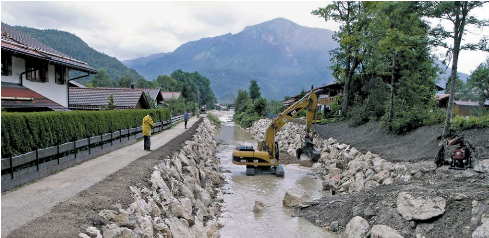
Erosionsschutz am Ufer soll auf Dauer eine schadlose Durchleitung erlauben (Wössener Bach, Unterwössen).
