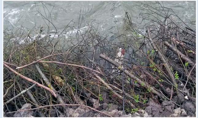
Geringeres Gefälle und wenig Geschiebetransport: ingenieurbioologische Ufersicherung maschinell eingebaut
