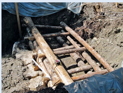
Bau einer Holzkastensperre
