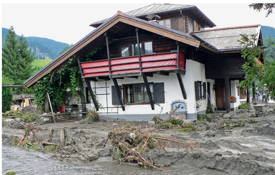
Schäden nach Hochwasser: Ablagerungen von Feststoffen, hier Hochwasser 2005 (Lkr. Oberallgäu)
