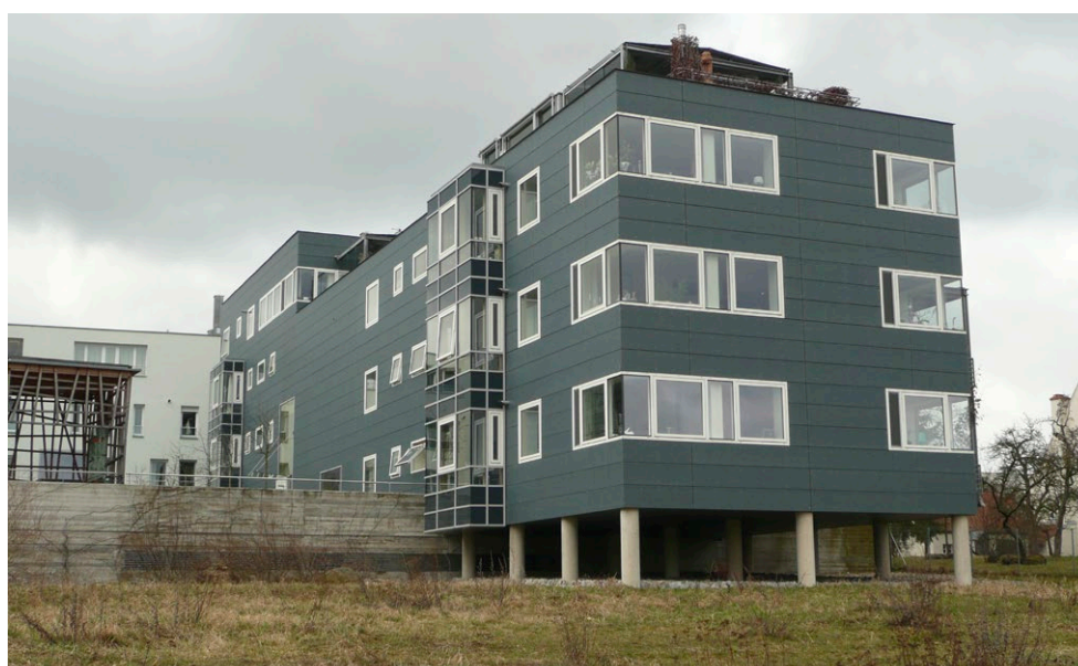
Hochwasserangepasste Bauweise – Links: Keine schadensanfällige Nutzung im Überflutungsbereich; Rechts: Abdichtung von Fenstern und Kellerabgängen.
