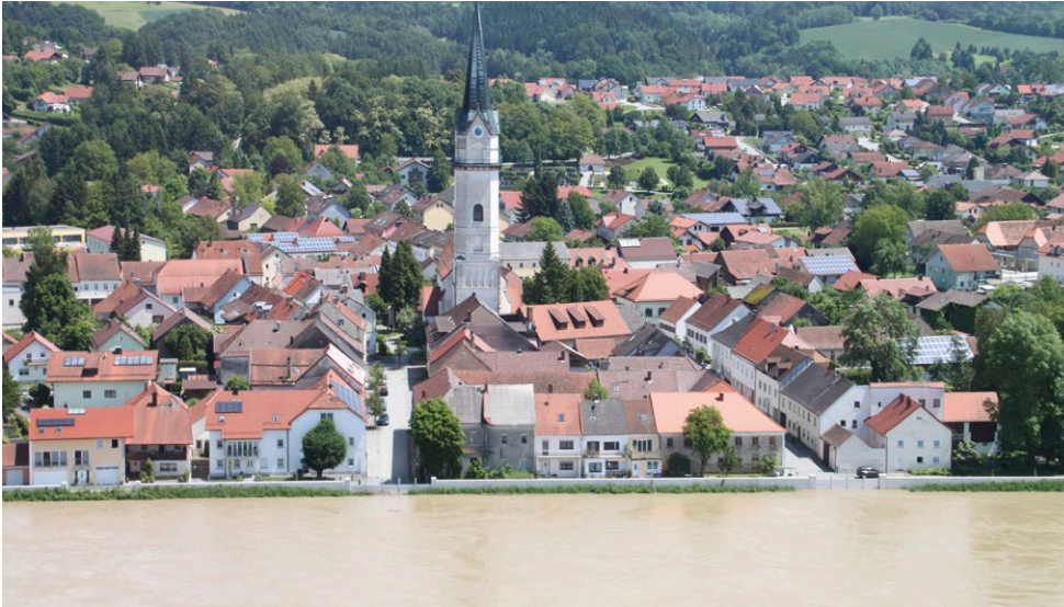
Der Hochwasserschutz von Hofkirchen verhindert Schäden im Ortsbereich.
