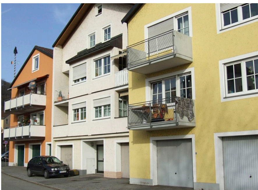
Bauvorsorge in der Passauer Ilzstadt – Verlagerung der Wohnräume in die oberen Stockwerke
