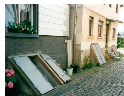
Hochwasserangepasste Bauweise – Links: Keine schadensanfällige Nutzung im Überflutungsbereich; Rechts: Abdichtung von Fenstern und Kellerabgängen.
