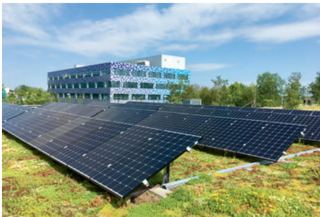
Nutzung erneuerbarer Energien bei staatlichen Baumaßnahmen: Kombination von Photovoltaik mit Dachbegrünung auf einem Gebäude auf dem Forschungscampus Garching.
