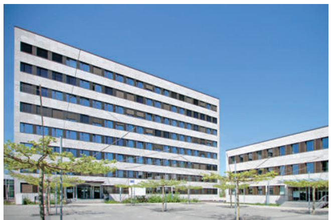
Sonderprogramm zur energetischen Sanierung staatlicher Gebäude: Landesamt für Finanzen und Staatliches Bauamt Würzburg, von der Europäischen Union aus dem Europäischen Fonds für regionale Entwicklung (EFRE) kofinanziert.
