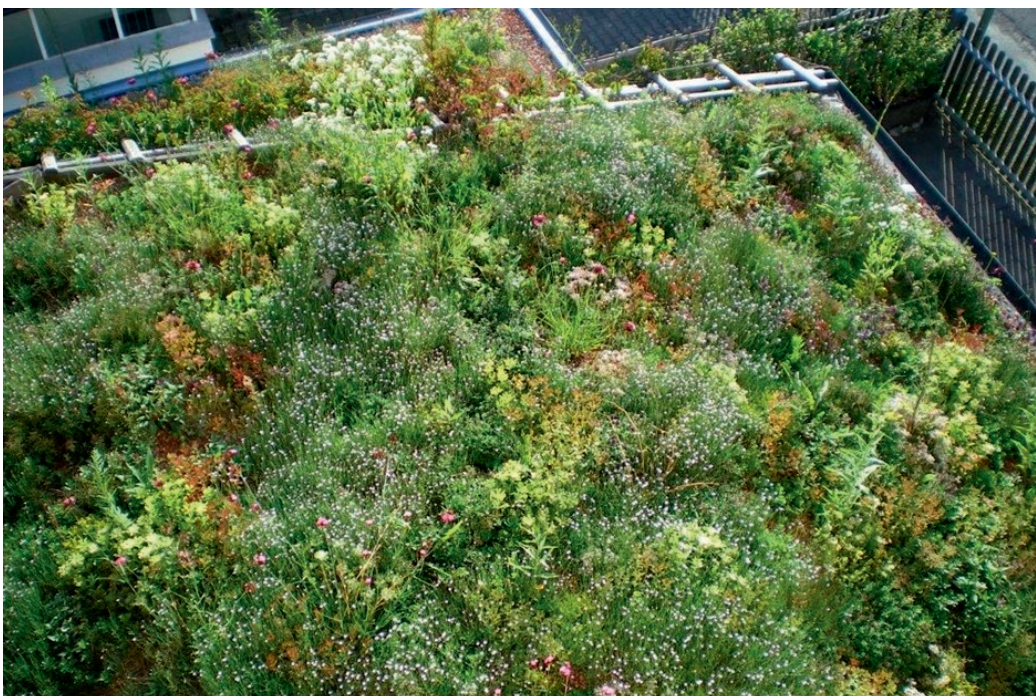
Abb. 20: Begrüntes Dach nach Abschluss der Sanierungsarbeiten
