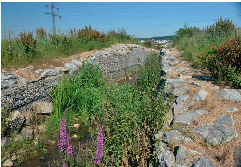
Abb. 36: Durch die Modellierung von vier Bodenwellen können bis zu 180.000 m 3 Wasser in der Fläche zurückgehalten werden.
