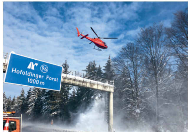
Abb. 82: Abblasen von Bäumen zur Verringerung der Schneebruchgefahr.
