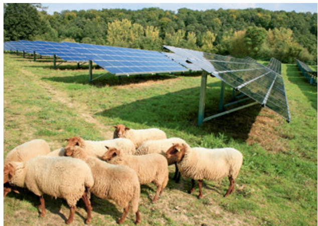
Abb. 83: Die Energiewende schreitet voran. Bis 2025 soll die Photovoltaik in Bayern dabei mit einem Anteil von 22 bis 25% an der gesamten Bruttostromerzeugung weiterhin eine entscheidende Rolle spielen.
