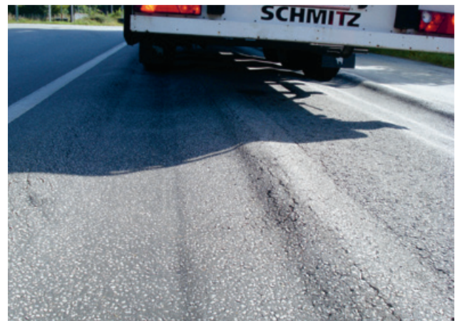
Abb. 81: Durch Hitze begünstigte Spurrinnenbildung.
