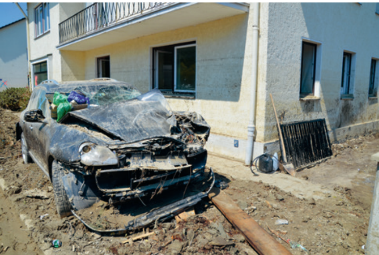
Abb. 89: In Simbach am Inn hinterließen die Wassermassen des Simbachs am 1. Juni 2016 ein Bild der Verwüstung.
