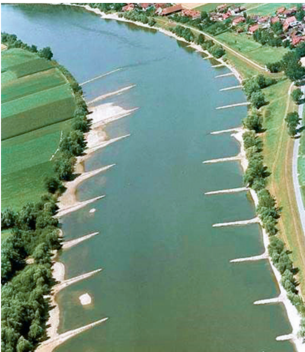
Abb. 80: Flussbauliche Maßnahmen bei Pfelling.
