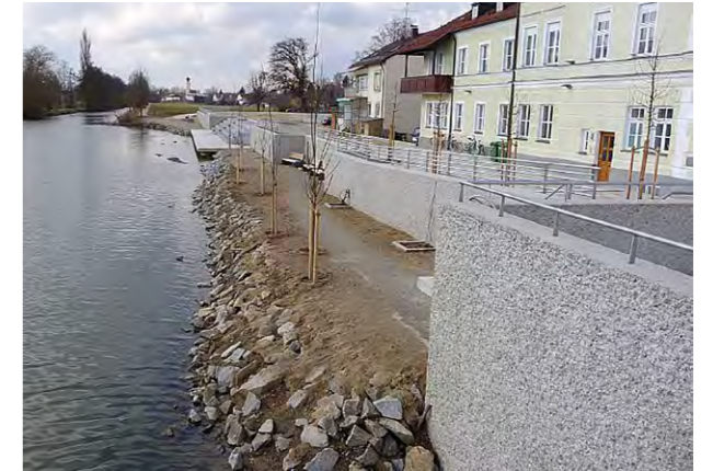
Hochwasserschutz an der Vils in Vilsbiburg
