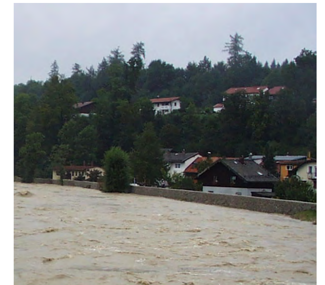
... 2002 stieg der Abfluss bis knapp unter diese Marke – bei noch höheren Abflüssen wären die Anlieger gefährdet
