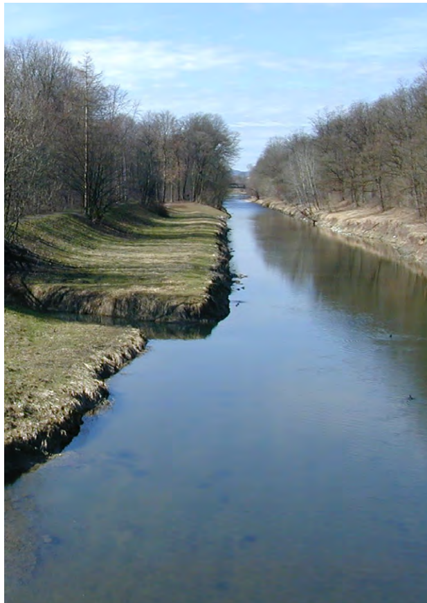
Das Ufer der Mangfall vor den Renaturierungsmaßnahmen
