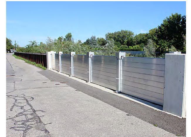
Mobile Elemente in Kolbermoor nahe Rosenheim
