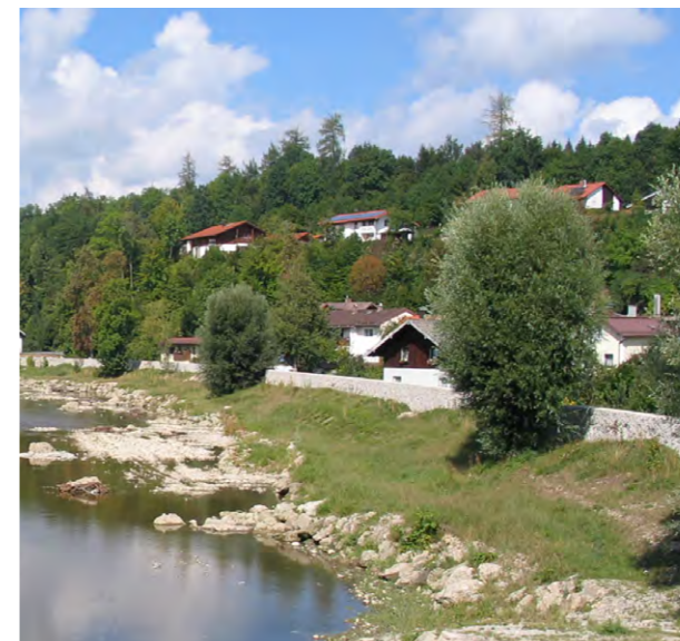
Der Hochwasserschutz am Traunufer in Traunstein schützt die Anlieger bis zu einem 100-jährlichen Hochwasser...
