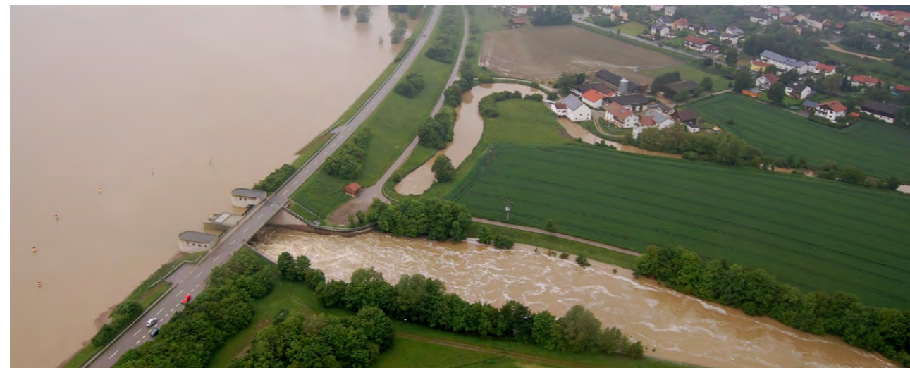
Das Auslassbauwerk des Vilstalsees beim Hochwasser im Juni 2013
