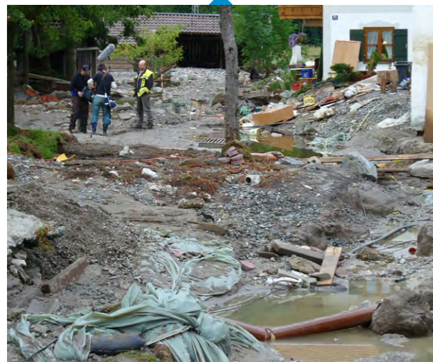
Schäden durch das Hochwasser der Loisach 2005 in Eschenlohe
