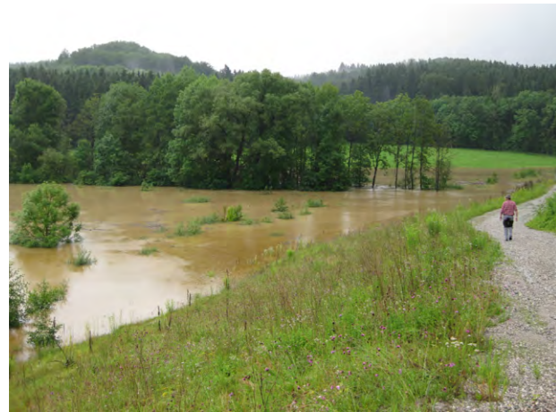
Das Hochwasserrückhaltebecken bei Wilzhofen und Wielenbach am Grünbach bei Hochwasser
