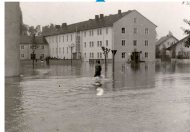
Das Hochwasser 1954 bei der Landwirtschaftsschule von Landau
