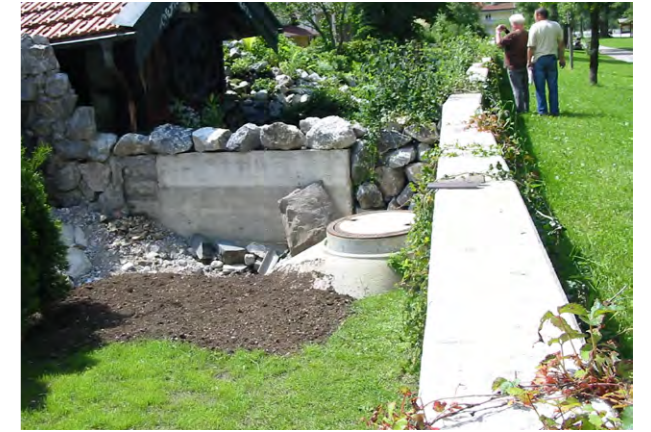
Bepflanzte Hochwasserschutzmauer in Bad Tölz
