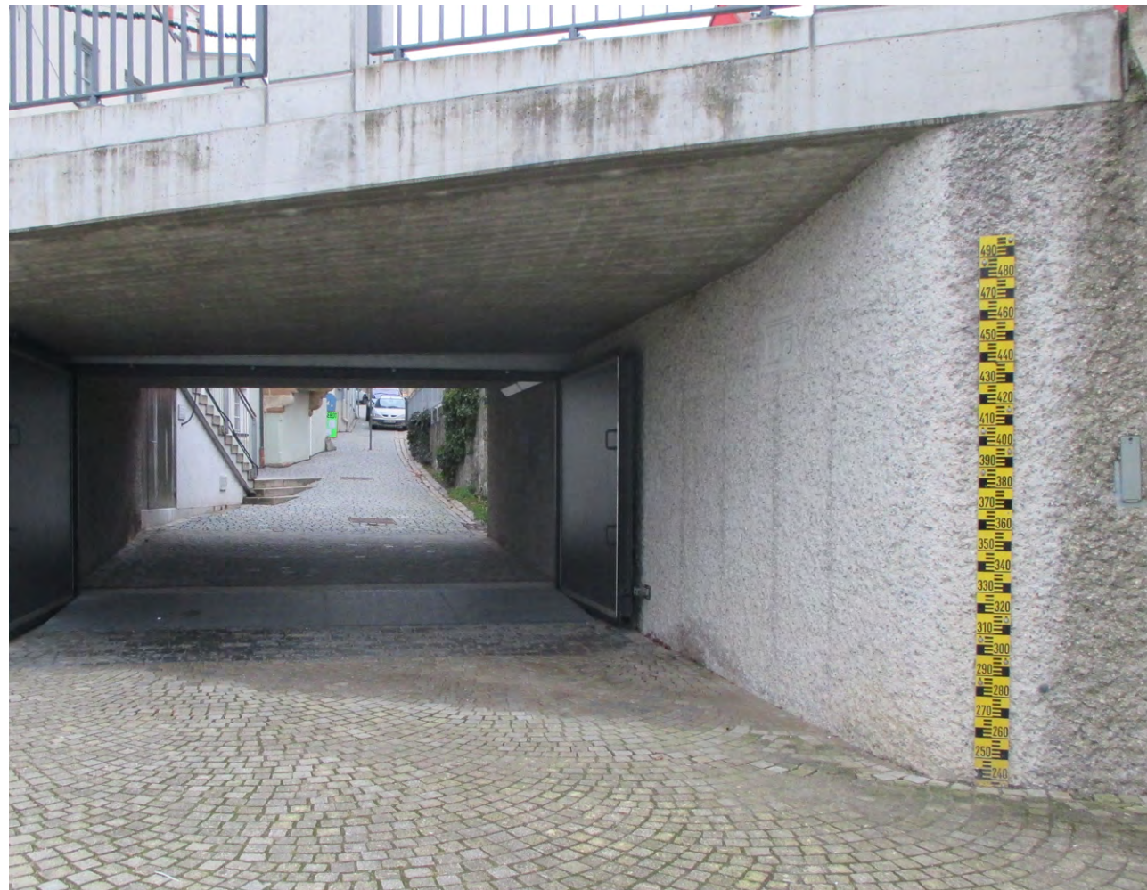
Eine Pegelmarke bei einer Fußgängerunterführung mit integriertem Hochwasserschutztor in Roding
