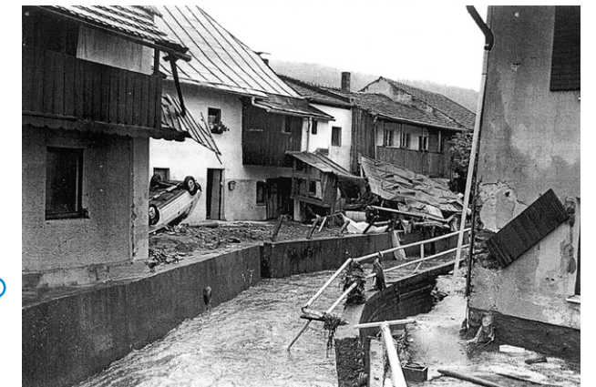
Schäden in Neukirchen nach der Flutwelle
