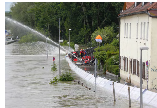
Einsatzkräfte beim Abpumpen hinter mobilen Elementen
