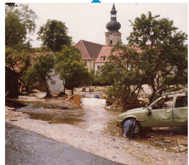
Schäden in Ensdorf nach der Überschwemmung
