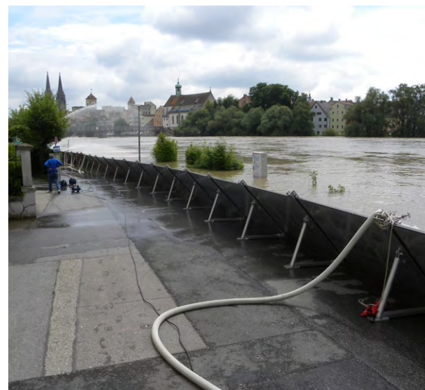
Mobiler Hochwasserschutz an der Badstraße in Regensburg beim Hochwasser 2013
