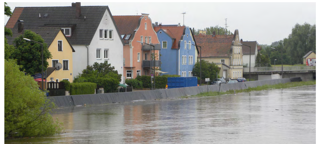
Mauern und mobile Elemente in Regensburg schützen anliegende Wohngebiete bis zu einem 100-jährlichen Hochwasser (bei extremeren Ereignissen sind die Häuser dahinter jedoch nach wie vor gefährdet)
