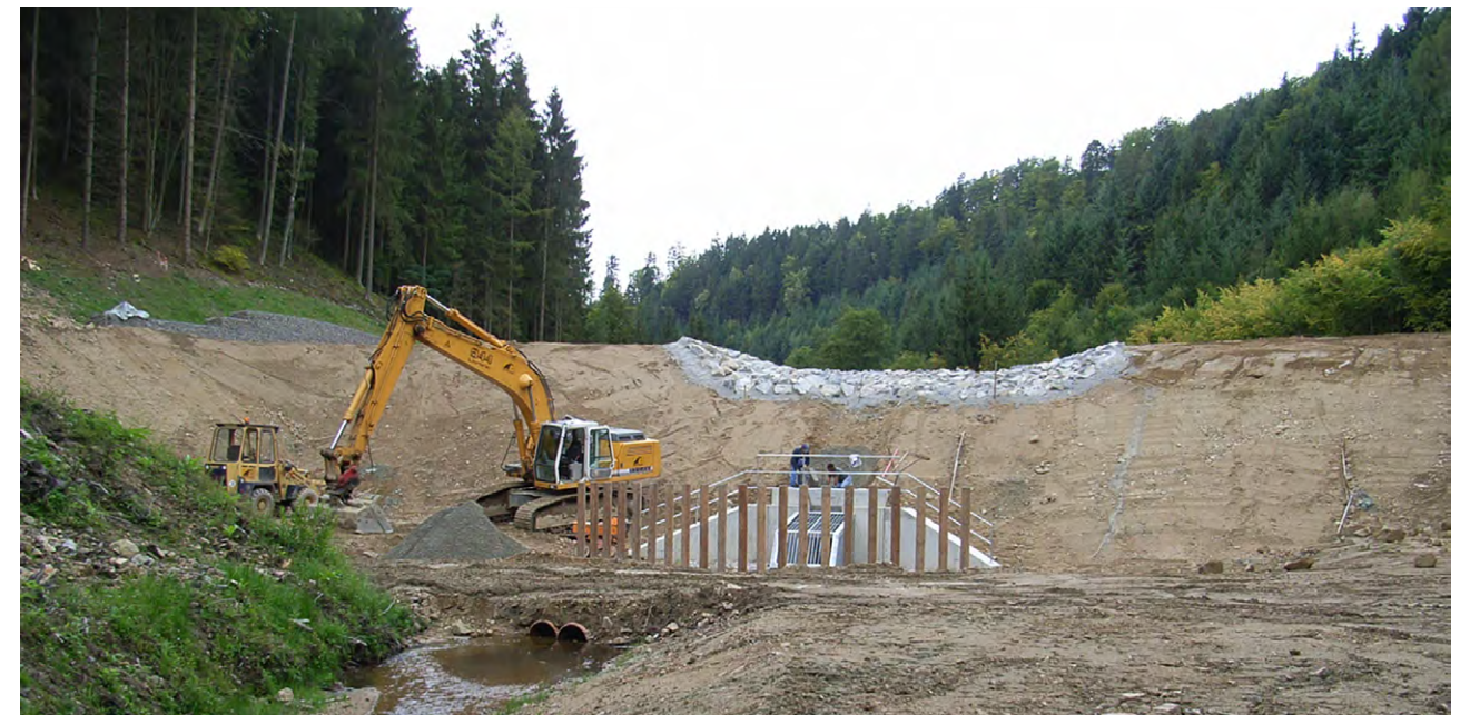
Das Hochwasserrückhaltebecken Holzlagerplatz bei Bach an der Donau nahe Regensburg kurz vor der Fertigstellung: Mit knapp acht Metern Dammhöhe kann das Becken rund 46.500 Kubikmeter Wasser zurückhalten, was in etwa einem 100-jährlichen Hochwasser entspricht
