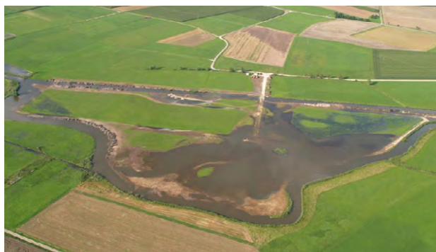
Bei Hochwasser wird in dem renaturierten Bereich Wasser zurückgehalten
