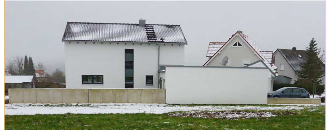
Betonmauern zum Schutz vor Hangwasser
