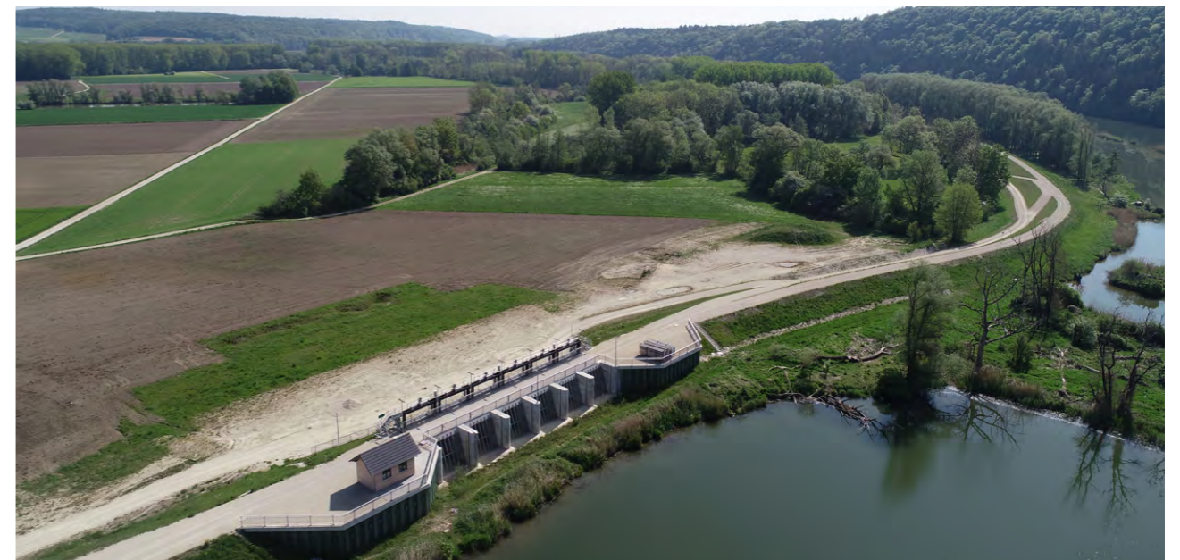
Das Einlassbauwerk des Flutpolders Riedensheim (auf den Feldern dahinter wird im Hochwasserfall Wasser zurückgehalten)
