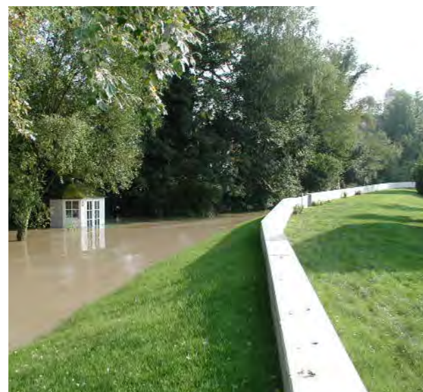
Deich mit Schutzmauer bei Neuburg an der Donau
