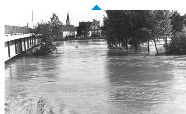
Der Donauegel stieg 1965 bis unter den Rand der Brücke bei Vohburg
