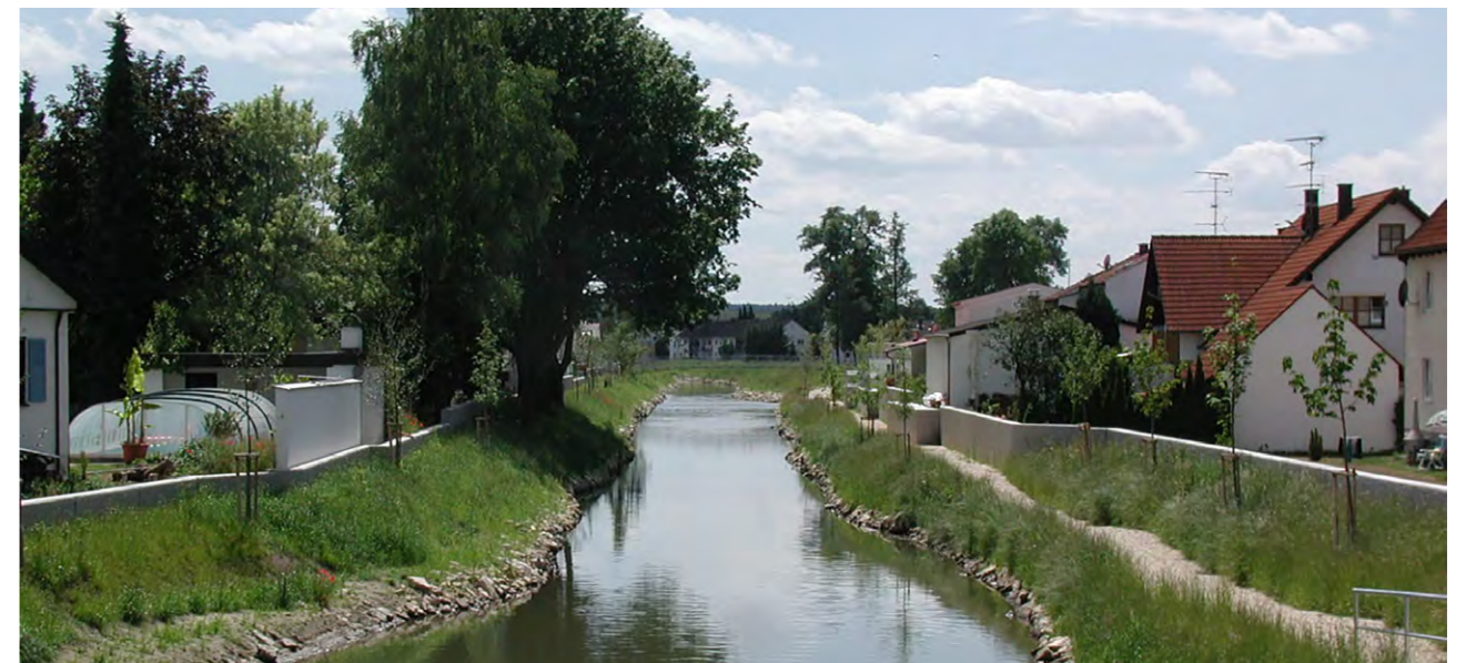
Wohngebiete in Geisenfeld sind unter anderem durch Hochwasserschutzmauern vor bis zu 100-jährlichen Hochwasserereignissen geschützt, noch höhere Wassermengen stellen aber nach wie vor ein Risiko für die Anwohner dar
