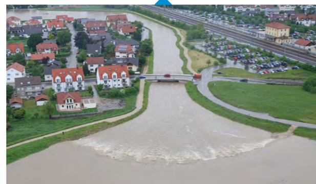
Der Einlaufbereich der Flutmulde in Rohrbach beim Ilmhochwasser im Juni 2013
