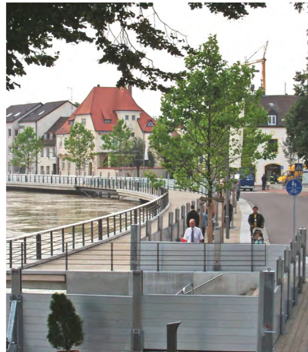
Mobile Schutzwände in Neuburg an der Donau
