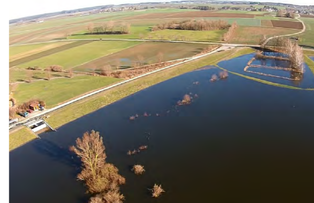
Probestau des Rückhaltebeckens Putzmühle an der Paar
