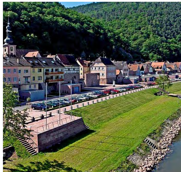
Der Hochwasserschutz in Freudenberg am Main kann mit mobilen Elementen erweitert werden
