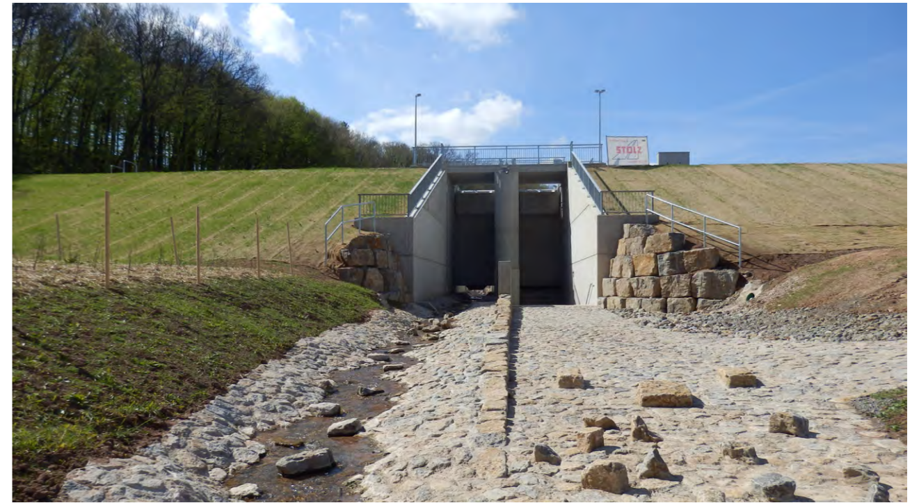
Hochwasserrückhaltebecken in Burglauer
