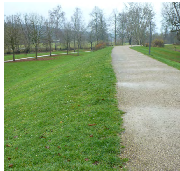
Deichanlage an der Fränkischen Saale in Bad Kissingen
