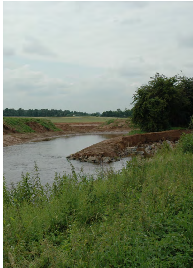
Die Kahl bei Alzenau während der Bauphase
