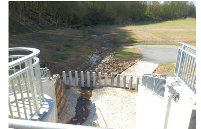
Hochwasserrückhaltebecken in Burglauer
