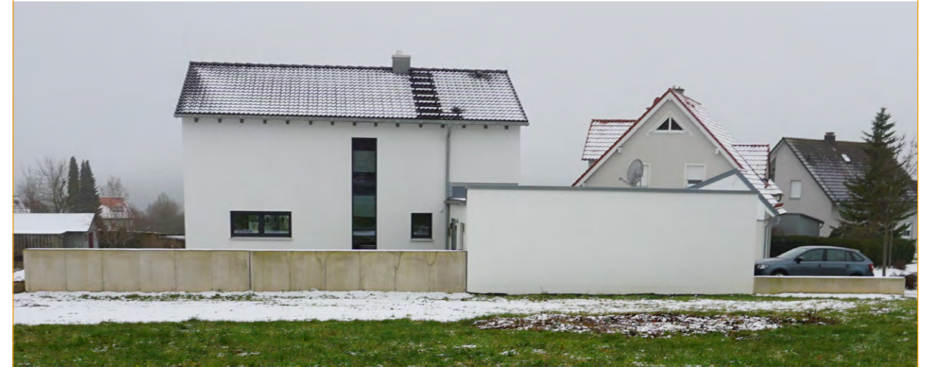
Betonmauern zum Schutz vor Hangwasser
