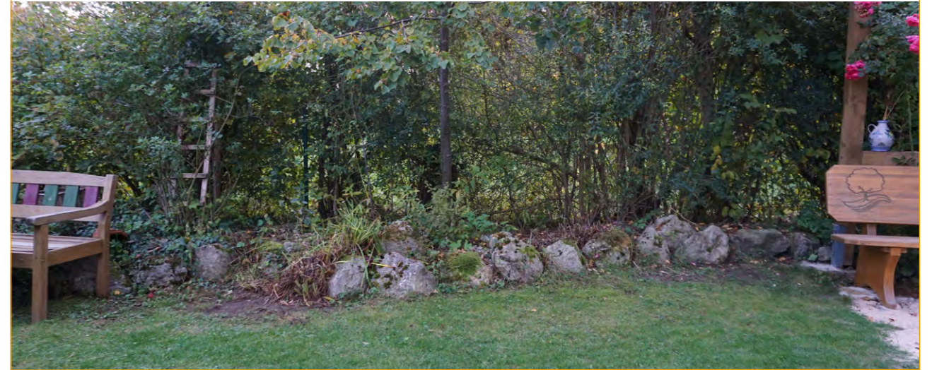
Steinwall zum Schutz vor Hangwasser
