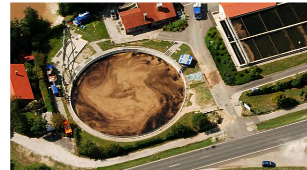
In der Kläranlage sind die Ölschlieren deutlich sichtbar
