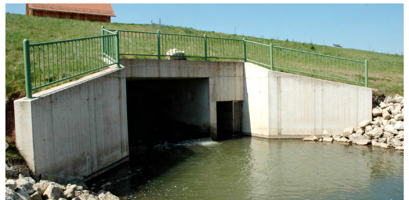
Das Auslaufbauwerk am Rückhaltebecken Burghaslach (nicht im Bild: eine angelegte Fischtreppe, die die Durchgängigkeit der Haslach garantiert)
