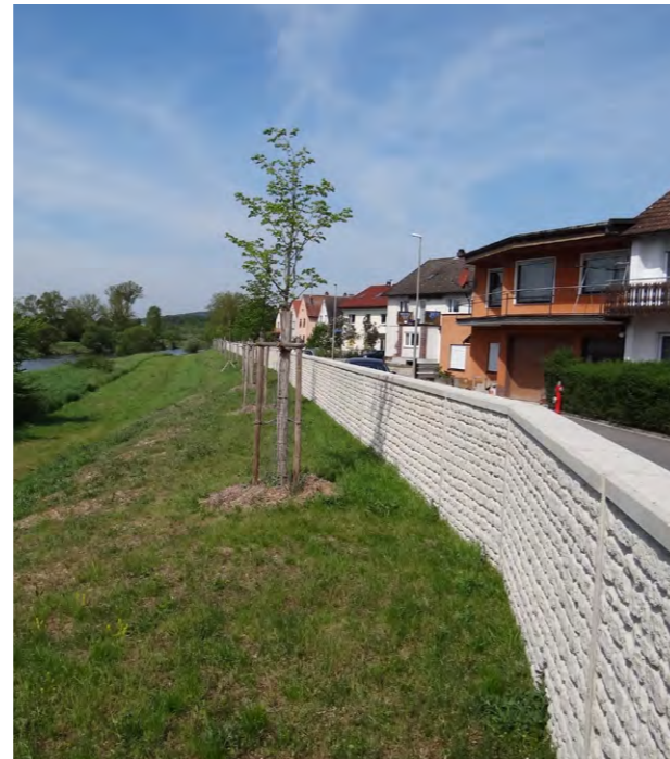
Hochwasserschutzmauer in Hirschaid
