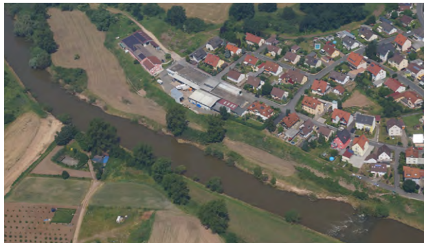
Die Regnitz bei Hirschaid vor dem ökologischen Ausbau
