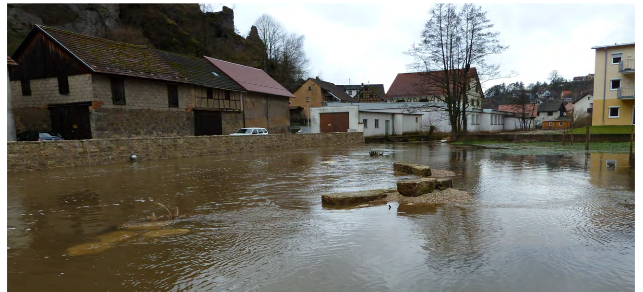
Bei einem extremen Hochwasserereignis wären auch die Gebäude hinter der Hochwasserschutzmauer in Pottenstein gefährdet
