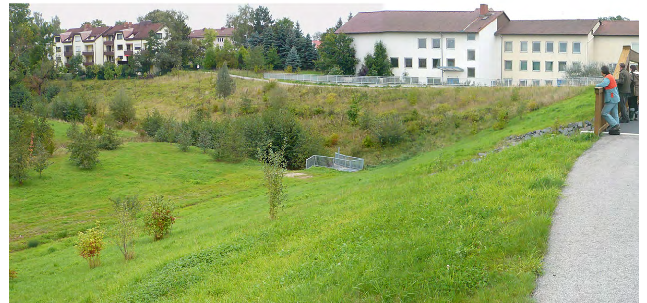
Rückhaltebecken am Rottenbach in Coburg
