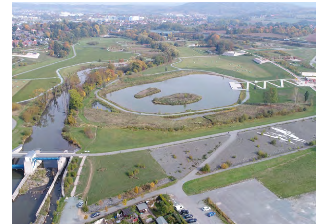
Hochwasserrückhaltebecken am Roten Main in Bayreuth
