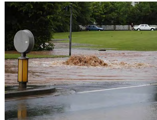
Wassermassen drücken aus einem Kanal
