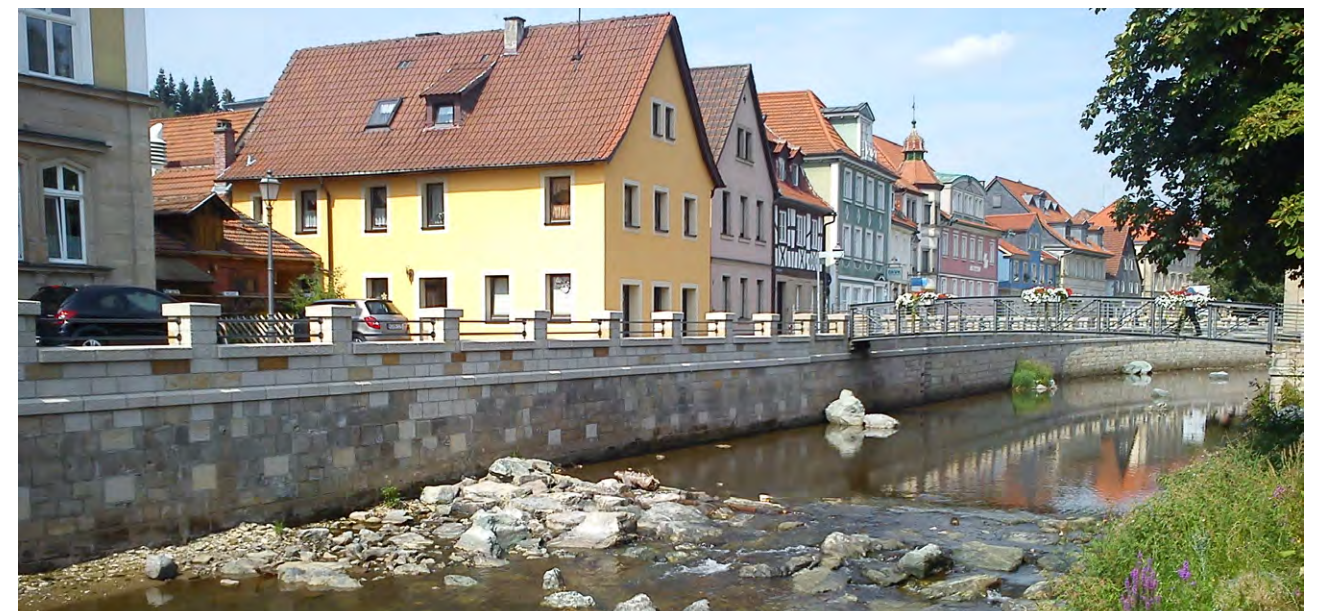
Bei einem extremen Hochwasserereignis wären auch die Gebäude hinter der Hochwasserschutzmauer in Kronach gefährdet
