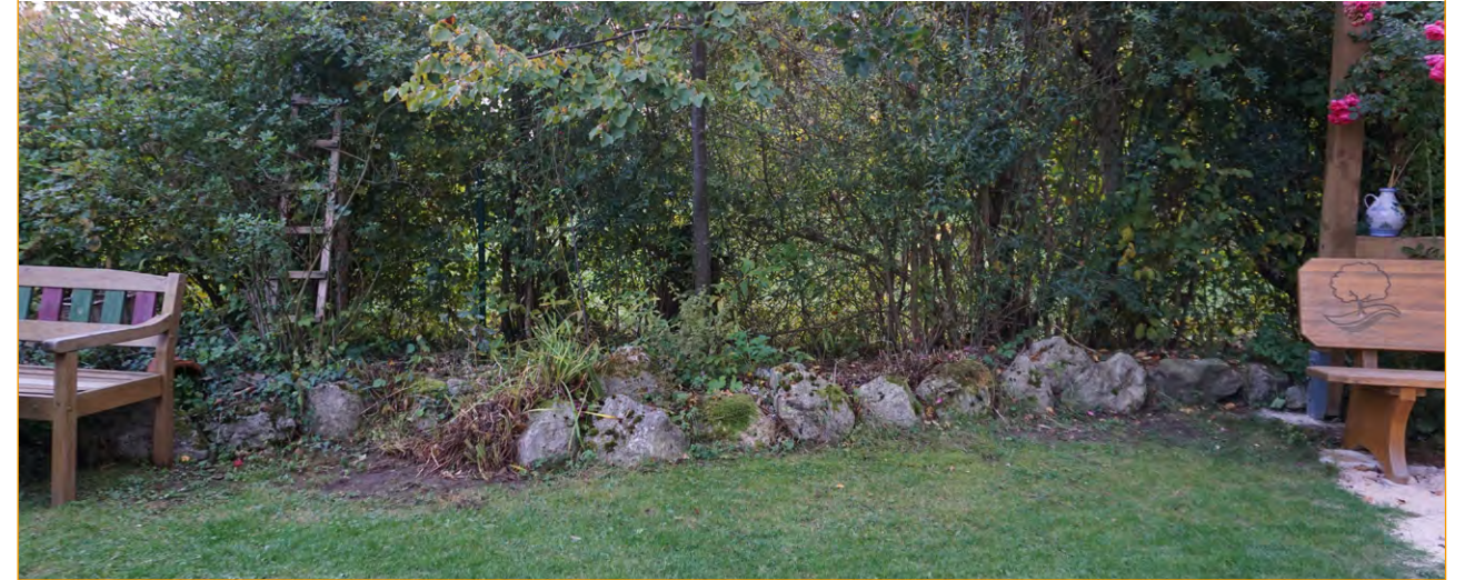
Wall zum Schutz vor Oberflächenwasser in Hummeltal
