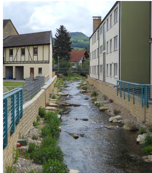
Hochwasserschutzmauern an der Lauter in Bad Staffelstein
