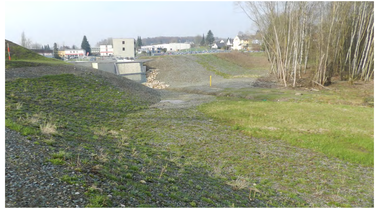
Hochwasserrückhaltebecken am Vielitzer Graben in der Stadt Selb – Blick über den Staubereich
