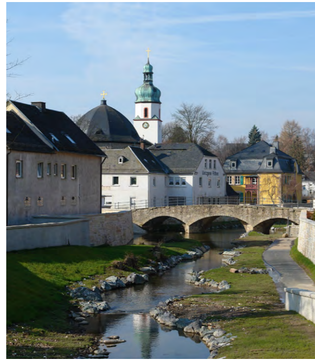
Hochwasserschutzmauern an der Schwesnitz in Oberkotzau
