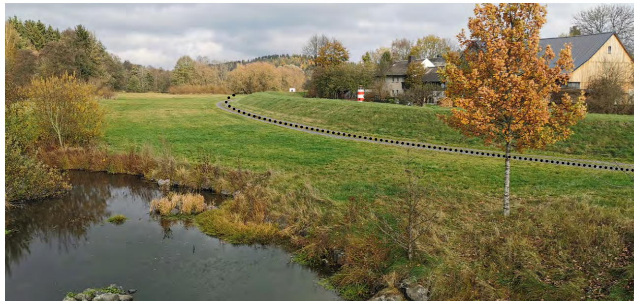
Saale, Hochwasserschutz Oberkotzau, Deich im Ortsteil Fattigau
