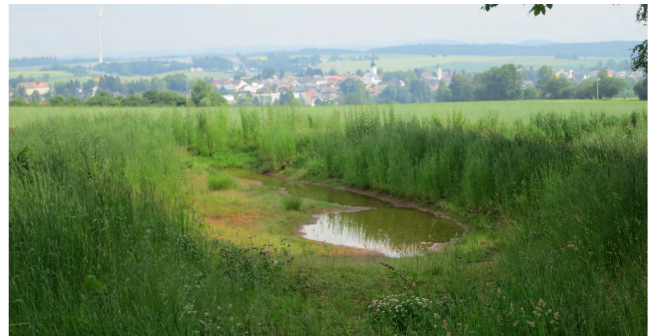
Rückhalte mulde für lokale Starkregenereignisse im boden:ständig-Projekt Thiersheim
