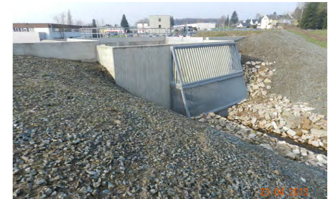
Der Auslauf des Rückhaltebeckens Vielitzer Graben nach Fertigstellung
