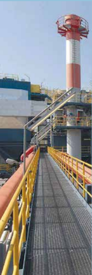
gsb Sonderabfall-Entsorgung Bayern GmbH in Baar-Ebenhausen: Außenansicht der Anlage
