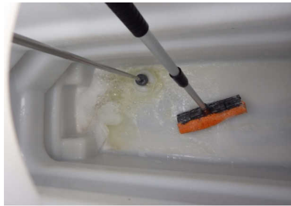
Abb. 37b: Mechanische Reinigung mit Wischer und Schwamm
