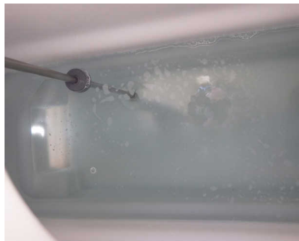
Abb. 37d: Tank beim ersten Spülvorgang
