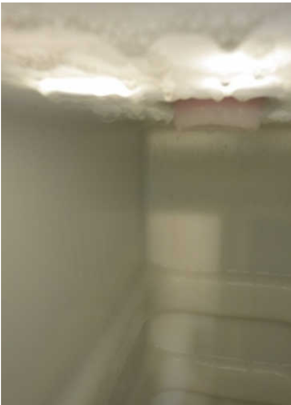
Abb. 37c: Schaummittelreste an der Tankdecke und den Tankwänden müssen mit möglichst heißem Wasser (50–60 °C) gelöst werden.
