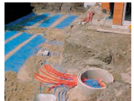
Einbau eines Kapillarrohrmatten-Erdwärmekollektors bei einem Neubauprojekt.
