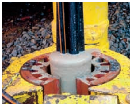
Zementation der eingebauten Doppel-U-Erdwärmesonde.
