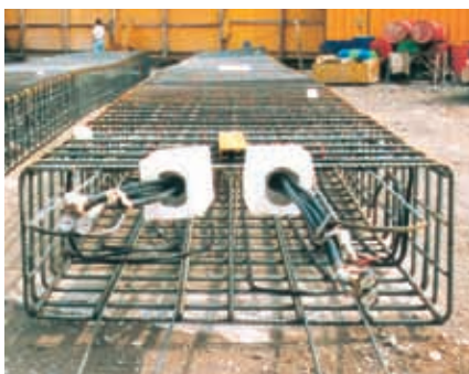
Mittels Wärmetauschersystem aufgerüsteter Armierungskorb einer Energieschlitzwand.
