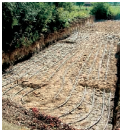
Einbau eines Kapillarrohrmatten-Erdwärmekollektors bei einem Neubauprojekt.
