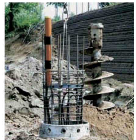
Einbau des Energiepfahl-Armierungskorbes in die mittels Mantelrohr stabilisierte Schneckenbohrung.
