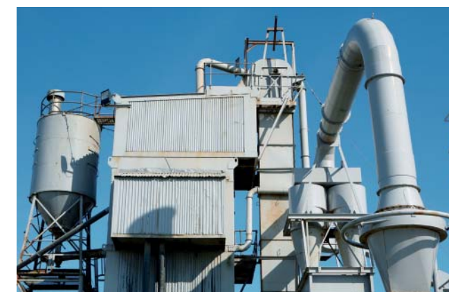
Zementfabrik Foto: Shutterstock
