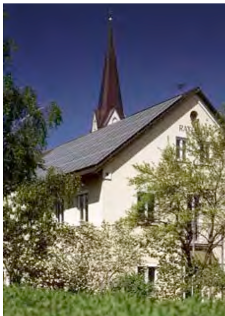
Die 14-KWp-Photovoltaikanlage auf dem Rathausdach versorgt rechnerisch die komplette Verwaltung mit Solarstrom
