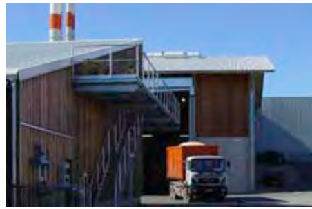
Hackschnitzelanlieferung am Biomasse-Heizkraftwerk
