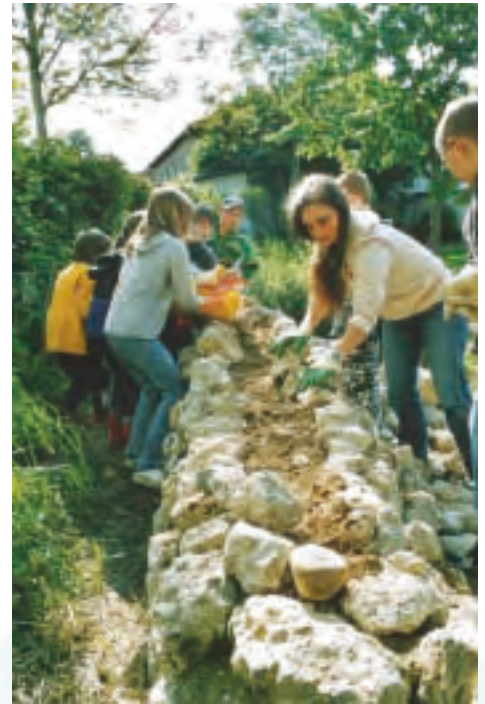
Reptilienprojekt: Bau einer Trockenmauer auf dem Schulgelände
