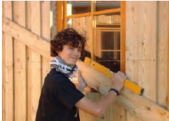
Unser FÖJ-ler Jan Schleicher beim Bau eines Häuschens für das Jugenddorf
