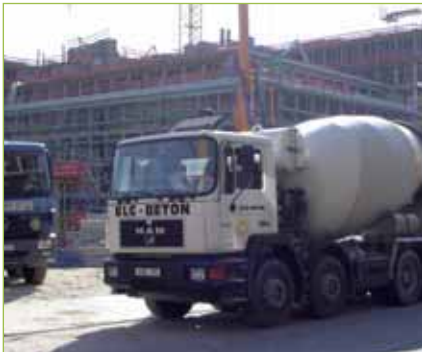
Abb. 4-5 Betontransport per LKW
