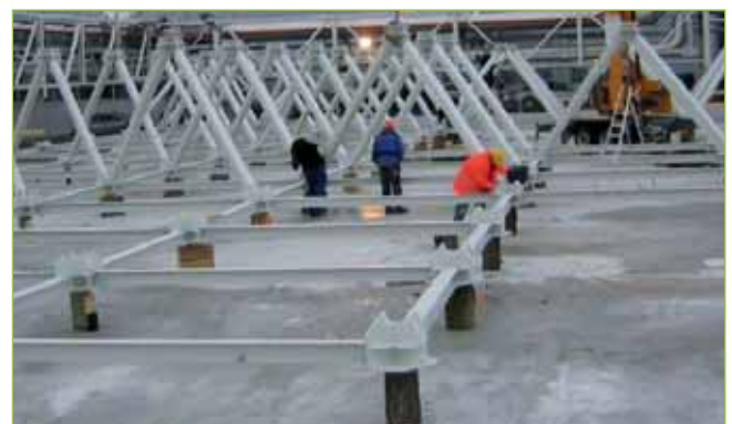
Abb. 3-7 Dachkonstruktion der Fertigungshalle während der Montage (Raster der Knotenpunkte 4 x 4m)
