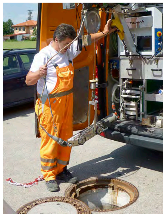
Ein Abwasserkanal wird untersucht.
