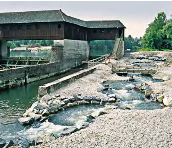
Wasserkraft als heimische, sichere und klimafreundliche Energiequelle ökologisch vertretbar nutzen (Foto: neu errichtetes Umgehungsgerinne am Ickinger Wehr an der Isar).
