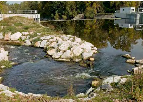
Umgebungsgewässer bei einer Wasserkraftanlage an der Wertach
