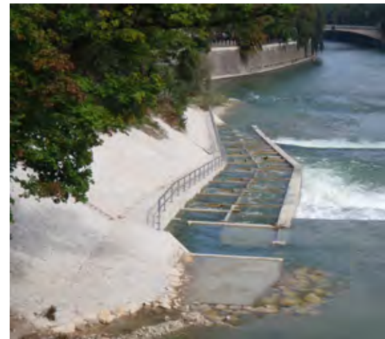
Fischaufstiegsanlage an der Isar in München (Foto: © Stefan Marx)
