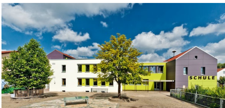
Grundschule Dürrwangen, die im Rahmen des Konjunkturpakets II energetisch saniert wurde
