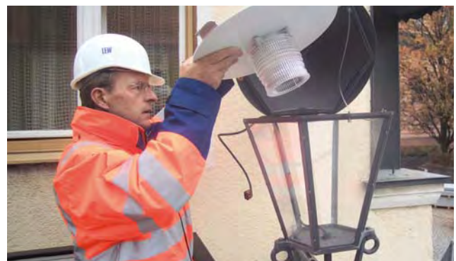
Umrüstung einer Leuchte in Friedberg Foto: Bernhard M. Schmid
