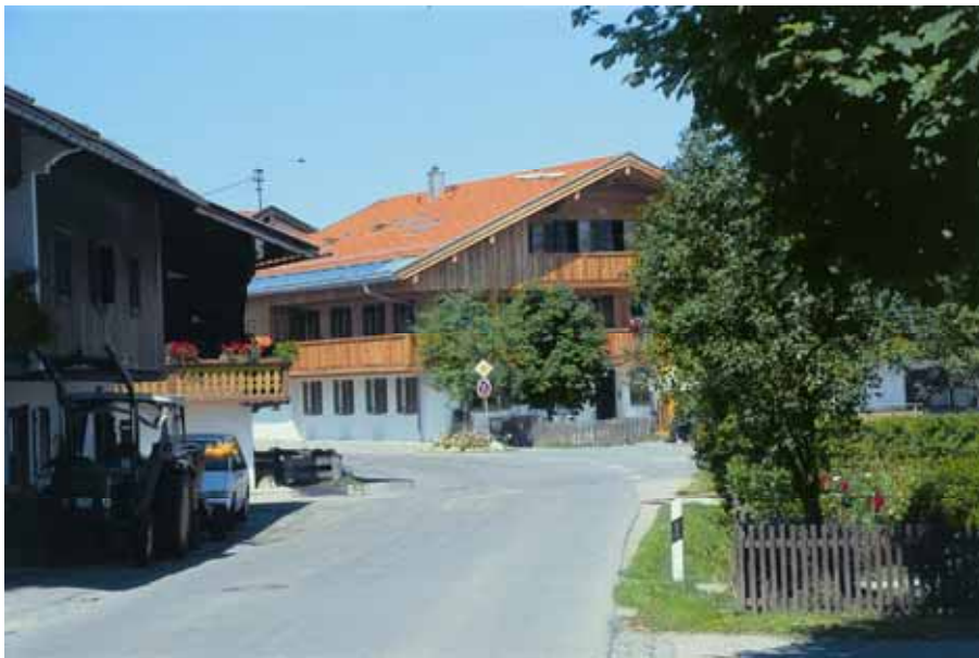
Abb 2: Ersatzbau für ein baufälliges ehemaliges landwirtschaftliches Anwesen in Greiling, Lkr. Bad Tölz-Wolfratshausen
