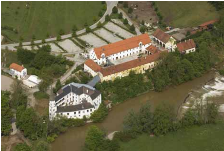
Abb. 1: Ersatzbau für ein abgebranntes ehemaliges Ökonomiegebäude in Pertenstein, Lkr. Traunstein
