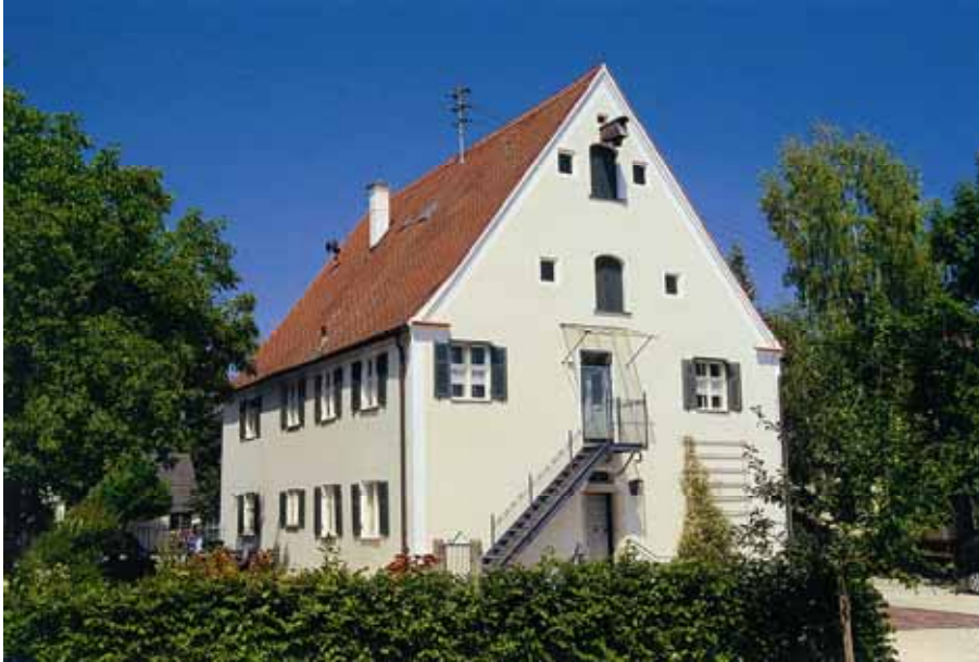
Abb 4: Sanierter Pfarrhof in Lutzingen, Lkr. Dillingen
