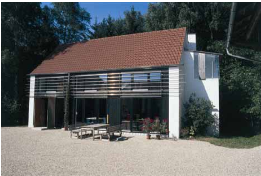
Abb. 8: Umgebaute Hopfendarre für Büronutzung in Lindach, Lkr. Kelheim
