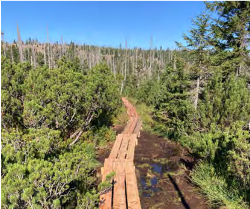
Um die moorigen Böden zu schützen, wurde auf einem Teil des Grenzsteigs zwischen Rachel und Lusen ein Bohlenweg gebaut.
