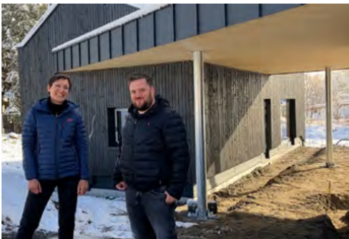
Nationalparkleiterin Ursula Schuster und Heiner Kilger, zweiter Bürgermeister der Gemeinde Mauth, bei der Besichtigung der Baustelle des Nationalpark Cafés.
