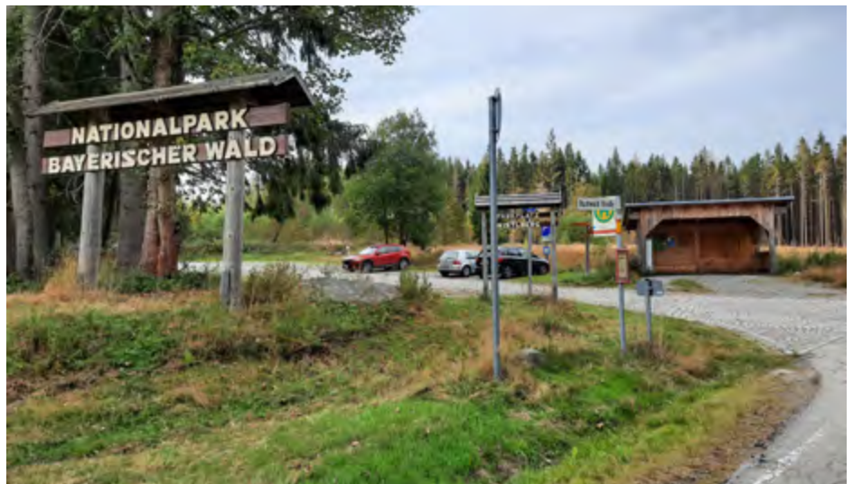
Der bestehende Parkplatz Wistberg bei Finsterau wird ausgebaut.
