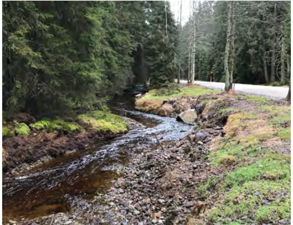
Im Rahmen der Sanierung der Schwarzachstraße wurden auch Gewässerunterhaltungsmaßnahmen durchgeführt.
