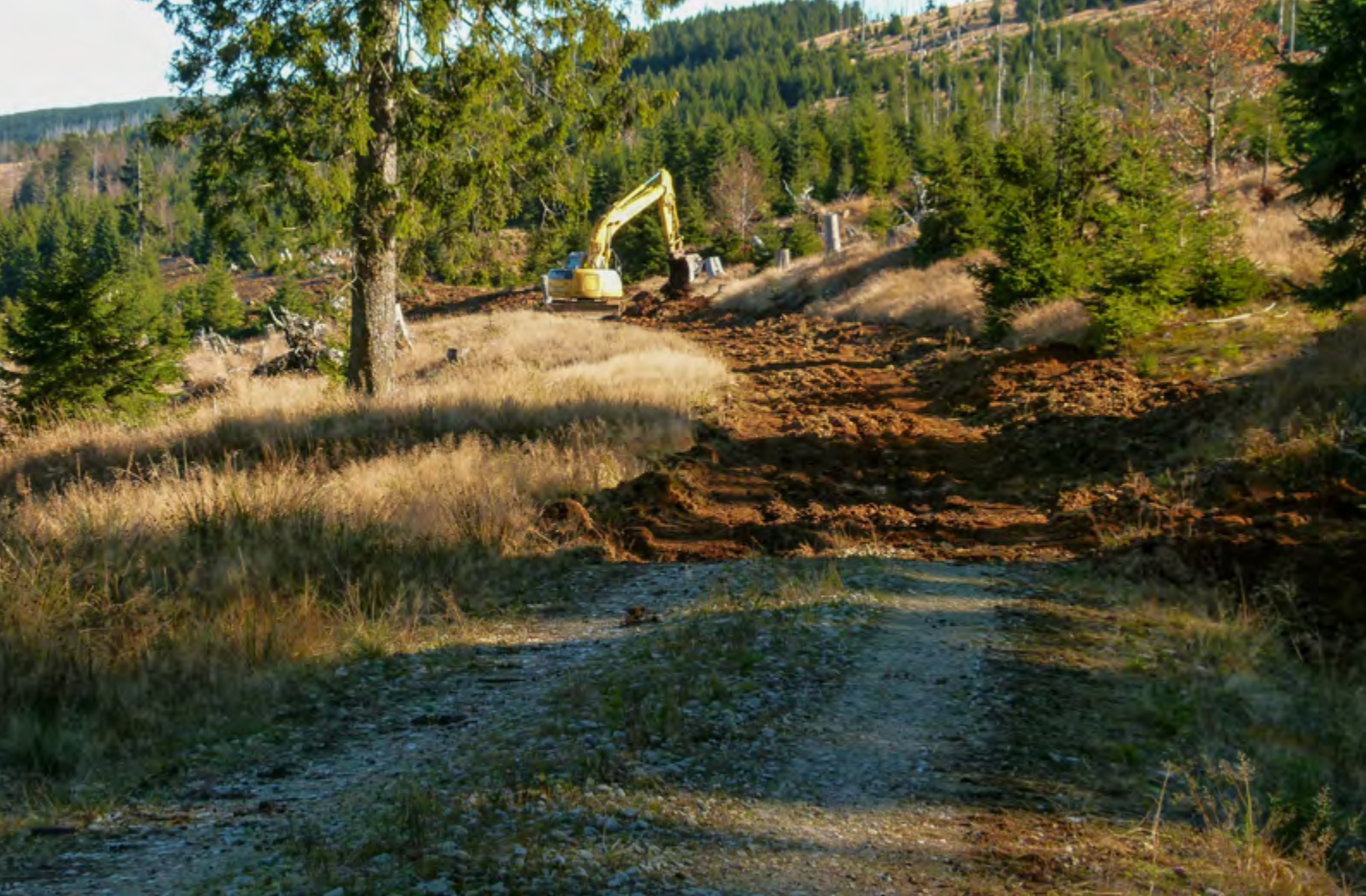
Die Gefällestraße konnte auf einer Länge von 1200 Metern zurückgebaut werden. Foto: Ingo Brauer
