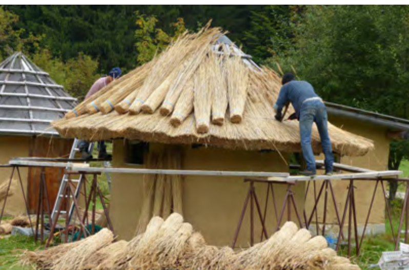
Drei Hütten im Wildnis Camp bekamen neue Reet-Dächer. Foto: Karl-Heinz Englmaier
