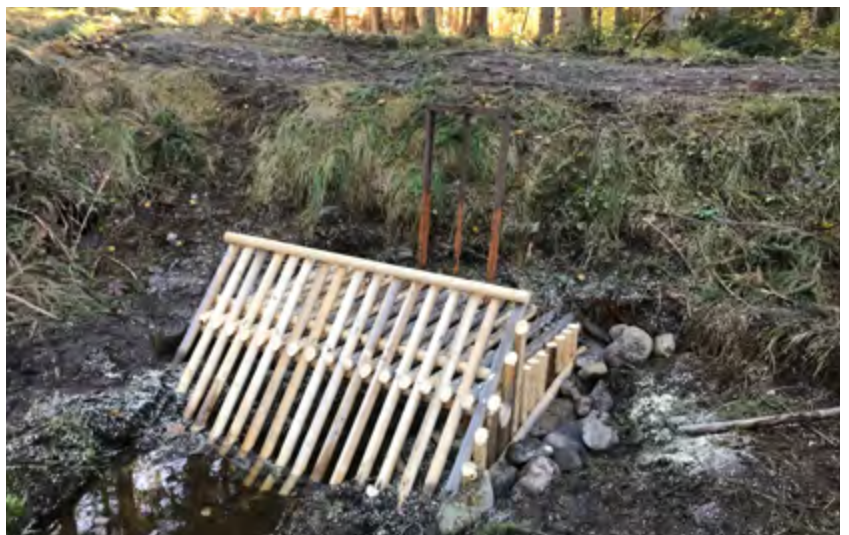
Beim Wanderweg „Bachstelze“ bei Lindbergmühle wurde vor einem Durchlass ein Biberrechen gebaut. Foto: Ingo Brauer
