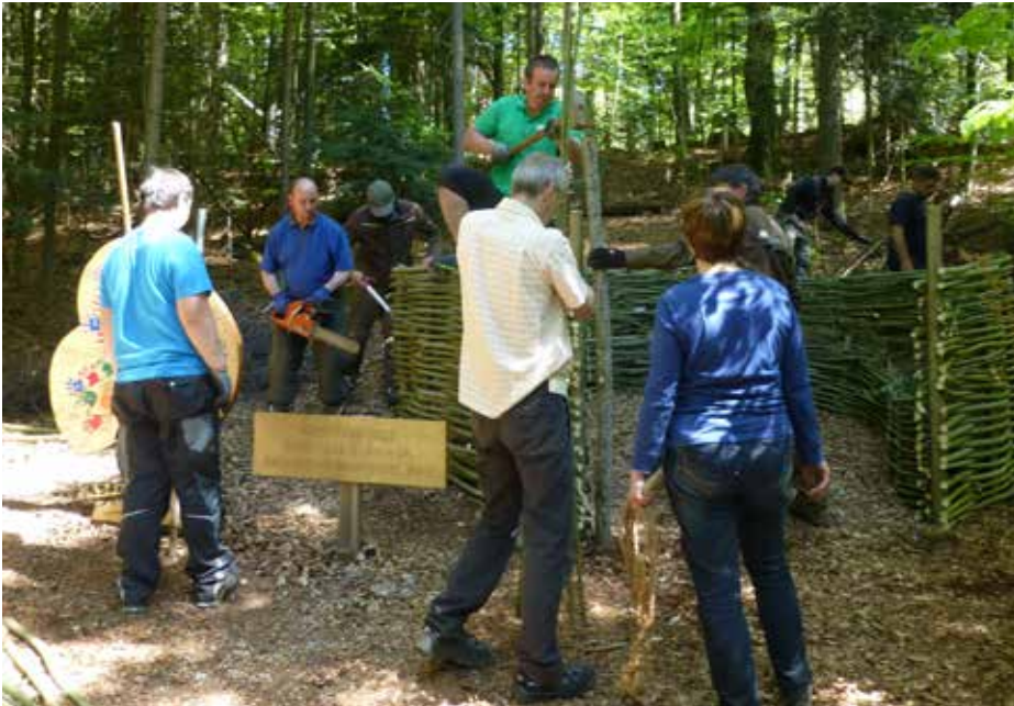
In Kooperation mit den Wolfsteiner Werkstätten errichteten Helfer mit und ohne Handicap im Pflanzen-Freigelände ein Weidensofa, das vor allem bei jungen Besuchern hoch im Kurs steht. Foto: Maria Hußlein
