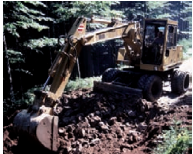
Ein Bagger leistet gute Dienste beim Wegerückbau (Foto: NPV).
