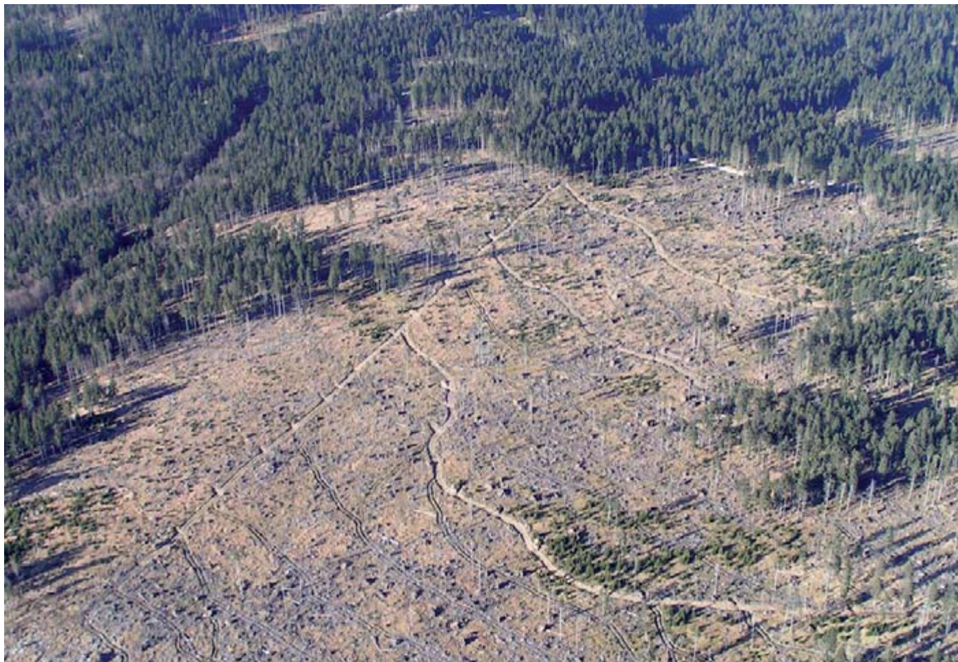
Bild 9: Durch das Räumen der Fläche erfolgt ein massiver Eingriff in die natürlichen Abläufe. Auf dem Bild erkennt man die tiefen Fahrspuren, die sich beim Abtransport des Holzes gebildet haben. Foto: Franz Baierl
