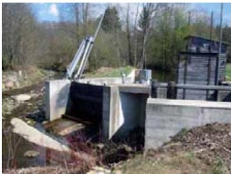
*Bestehende Kleinkraftwerke genießen Bestandsschutz. Bei der Modernisierung müssen Wehranlagen aber durchgängig für Fische gestaltet werden. Umgehungsgerinne sind heute Standard (Foto: Ingo Brauer)*
