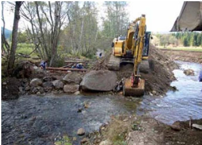
Wiederherstellung früherer Mäanderschleifen am zur Trift begradigten Kolbersbach - mit dem Bagger in wenigen Stunden erledigt (Foto: Ingo Brauer)
