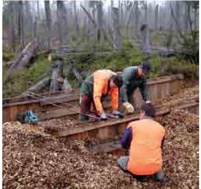
*Stabilisierung einer mit Hackschnitzeln gefüllten, 3 Meter hohen Doppelwand mit Eisenstangen, um ein Ausbauchen der Wände zu verhindern*
