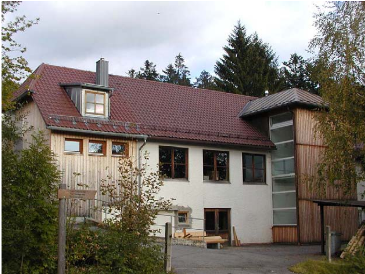
Ein Arbeitsschwerpunkt 2006 waren die Umbau- und Sanierungsmaßnahmen in der Schreinerei der Dienststelle Neuschönau
