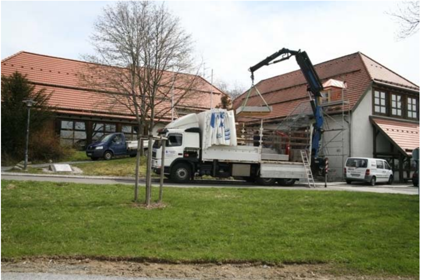
Schwerpunkt der baulichen Aktivitäten der Nationalparkverwaltung im Jahr 2007 war die Sanierung und der aus Brandschutzgründen erforderliche Umbau des Waldgeschichtlichen Museums St. Oswald.
