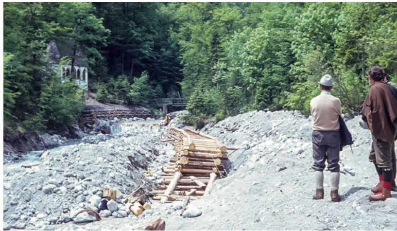
▲ Dammbau ... im Eisbachdelta: In den 1960er Jahren installierte das Wasserwirtschaftsamt mit großem Aufwand eine Krainerwand, um die Gebäude der Halbinsel St. Bartholomä zu schützen.
