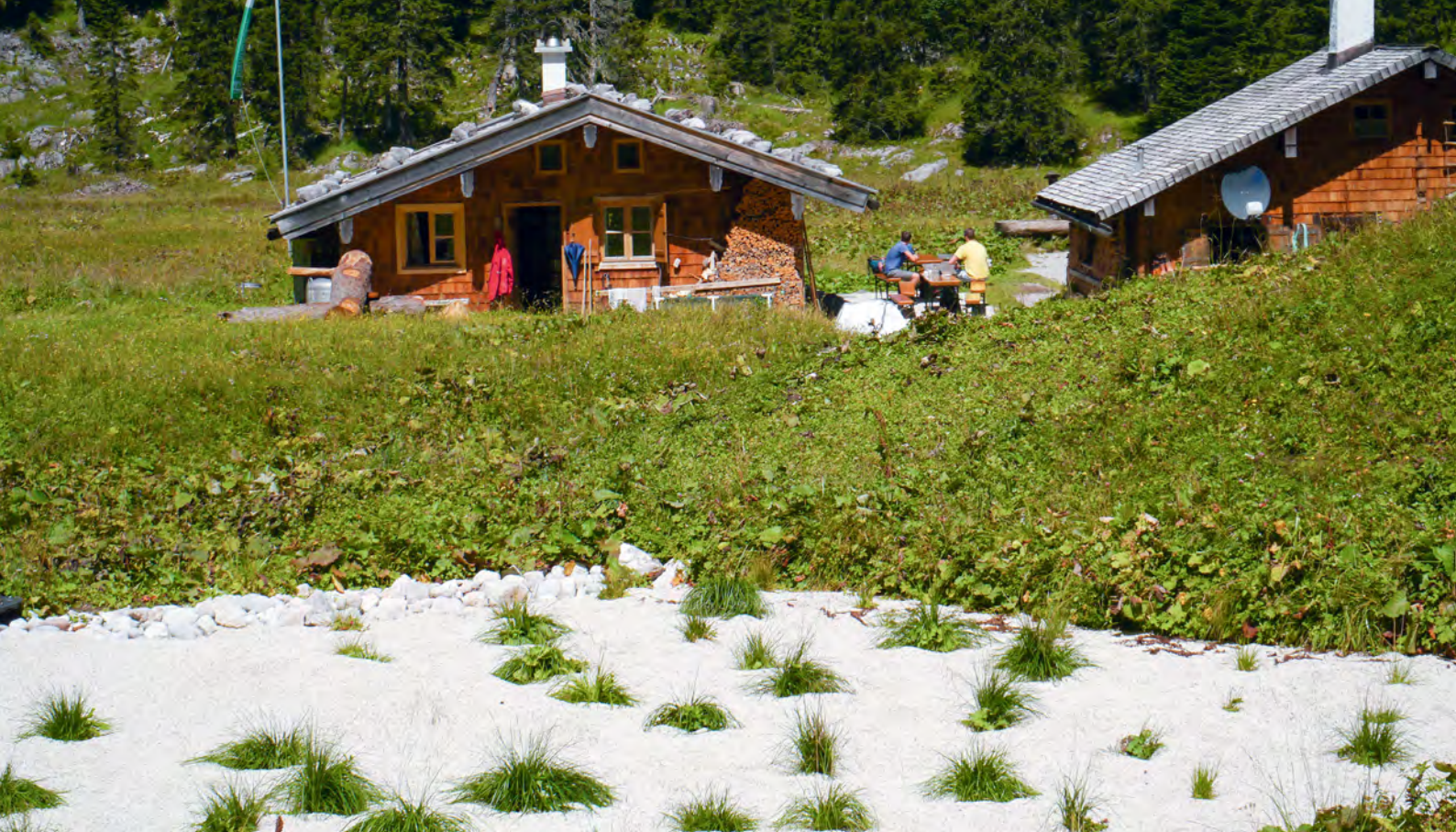
▲ Kleinkläranlage Mit einem Pflanzenklärbeet werden die flüssigen Abwasserbestandteile vor Ort in und von der Natur gereinigt.
