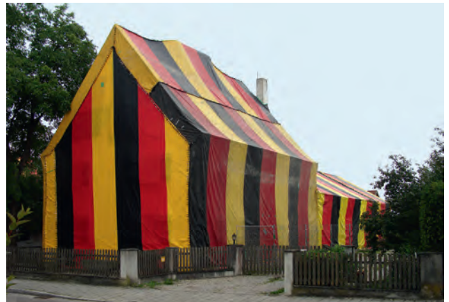
Abbildung 5: Ein Gebäude in Folie zu hüllen ist eine Möglichkeit, zu verhindern, dass Gas nach außen tritt.
