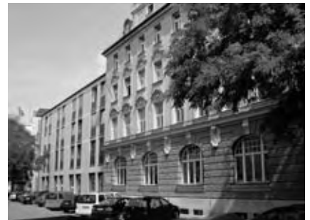
Abbildung 1.1d: Das Dienstgebäude Pfarrstraße in München
