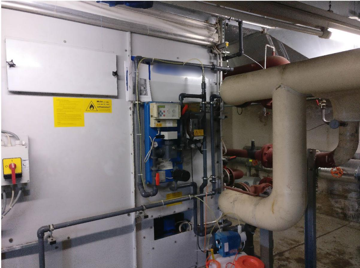
Abbildung 6: Live-Überwachung und Steuerung von Parametern wie z. B. pH-Wert, Leitfähigkeit und Redox-Spannung
