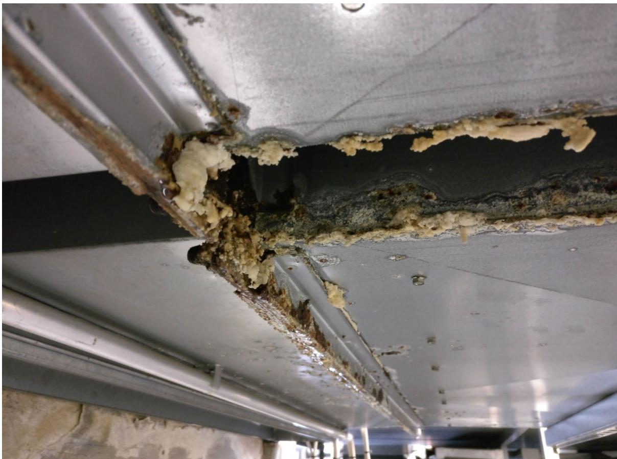
Abbildung 5: Beispiel für Salzablagerungen durch Korrosion. Diese Salzablagerungen werden zu geeigneten Wachstumsflächen für Bakterienbiofilme.
