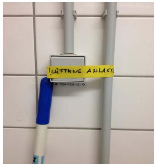
Abbildung 1.4: Klebestreifen zur Blockade der Ein- und Ausschalter für Lüftungsanlagen sind eher ungeeignet, den dauerhaften Betrieb der Lüftungsanlage sicherzustellen.
