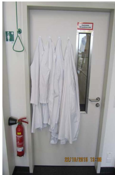
Abbildung 1.2: Türen in gentechnischen Anlagen müssen Sichtfenster aufweisen.
