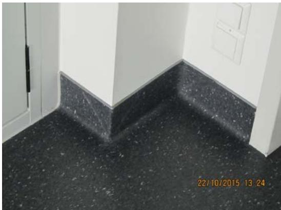
Abbildung 1.7: Es ist zweckmäßig, den Bodenbelag in Wannenform auszuführen, um Risse in den sonst benötigten Silikonfugen zu vermeiden.
