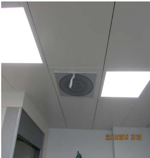
Abbildung 1.3: Papierstreifen an den Auslässen von Lüftungsanlagen ermöglichen eine schnelle Funktionsüberprüfung.
