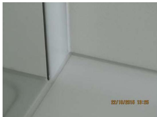
Abbildung 1.8: Ein besonderes Augenmerk ist bei Kontrollen auf die Silikonfugen an den Übergängen der Arbeits-, zur Wandfläche zu richten.
