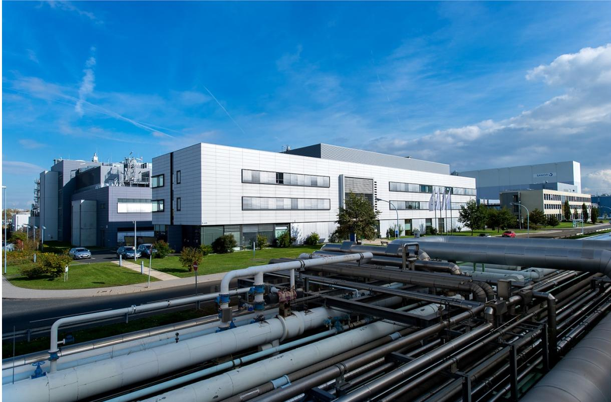
Abbildung 3.2: Der Lantus-Betrieb der Firma Sanofi im Industriepark Frankfurt am Main. Vorne befindet sich das Verwaltungs- und Laborgebäude, hinten links die Fermentation, in der Bakterien das Insulin produzieren. In den Rohranlagen werden die für die Produktion erforderlichen Rohstoffe und Medien, z. B. Luft, Stickstoff, Ammoniak und Dampf transportiert.
