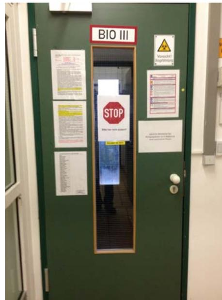
Abbildung 1.12: Kennzeichnung an den Eingangsbereichen zur gentechnischen Anlage gemäß Anhang III.A Nr. 1 GenTSV.
