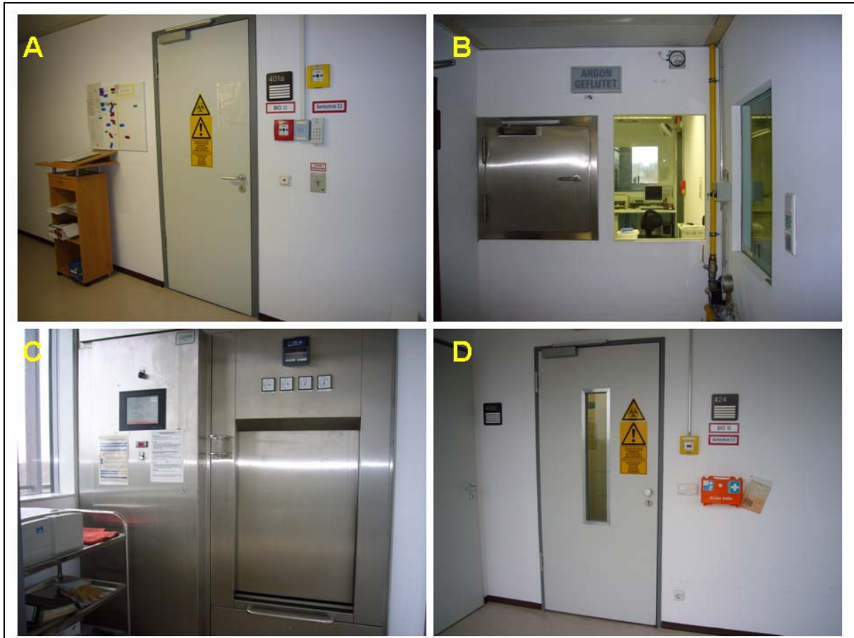
Abbildung 4.8: Personal- und Materialschleusen. A: Ein- und Ausgang für Personal. B: Materialschleuse zum Einschleusen von Probematerialien. C: Durchreicheautoklav zum Ausschleusen von Laborabfällen. D: Notausgang für Personal.
