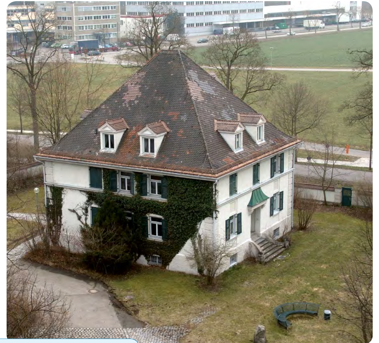
Das Direktorenhaus in seiner jetzigen Form, es wurde erhalten und beherbergt heute die EDV.
