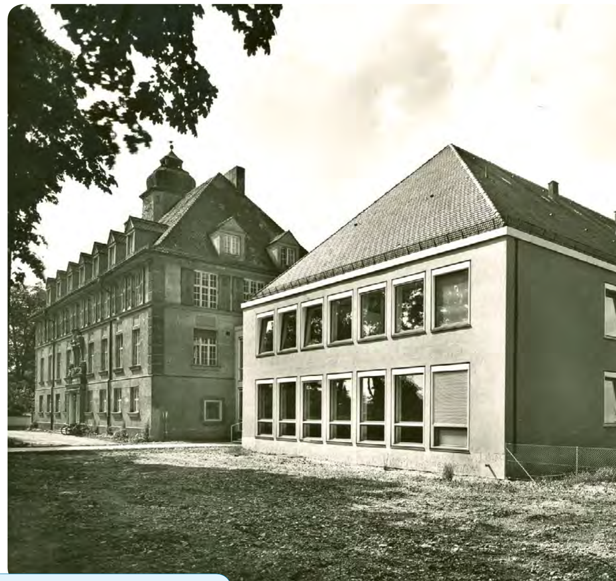
Anbau mit Hörsaal 1963
