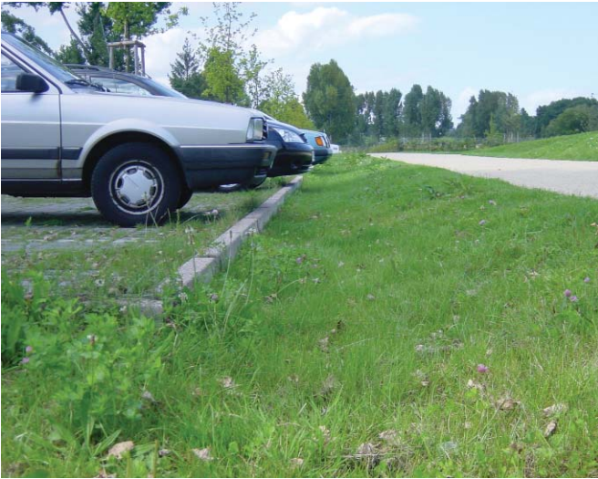
Abb. 60: Versickerungsmulde hinter Stellplätzen - breitflächiger Zufluss und flächenhafte Versickerung
