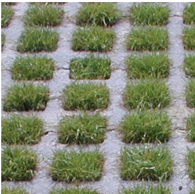
Abb. 8: Offene Poren im Belag schaffen Verdunstungs- und Versickerungsausgleich im urbanen Wasserhaushalt
