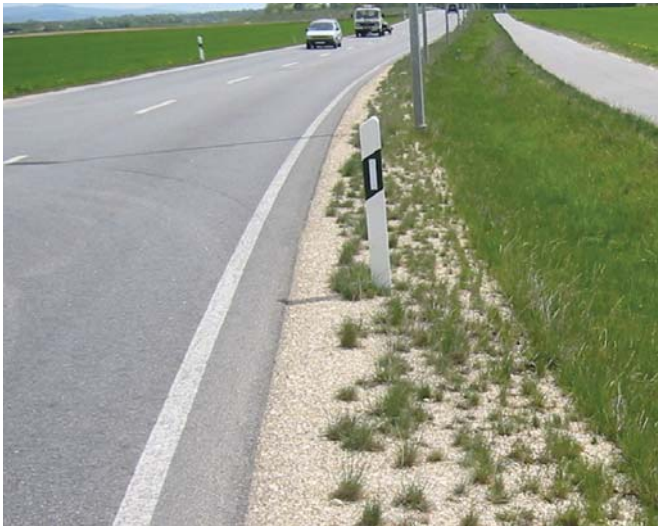
Abb. 52: Einfach und sehr wirkungsvoll - Randstreifen mit Mulde
