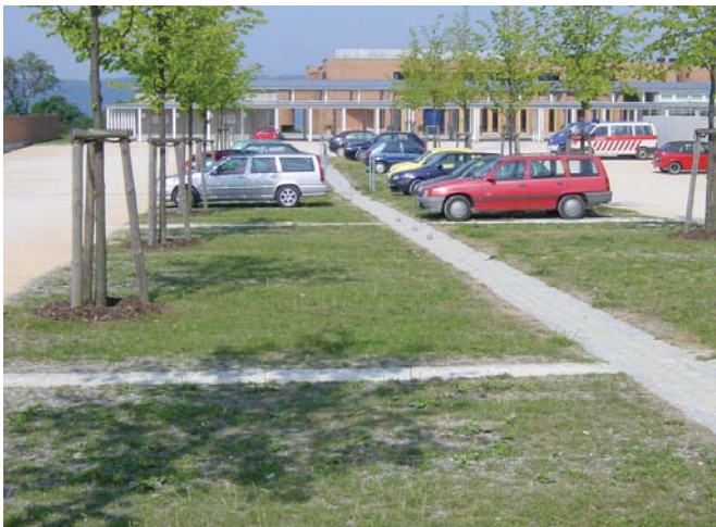
Abb. 32: Schotterterrassen auf Stellplätzen einer Schule
