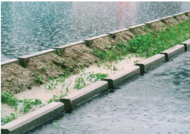
Abb. 23: Versickerung in einer Mulde zwischen zwei asphaltierten Parkplatzflächen. Bei ausreichender Versickerungsfähigkeit des Untergrundes und Vorreinigung über belebte Bodenzonen lässt sich der gesamte Regenwasserabfluss versickern.
