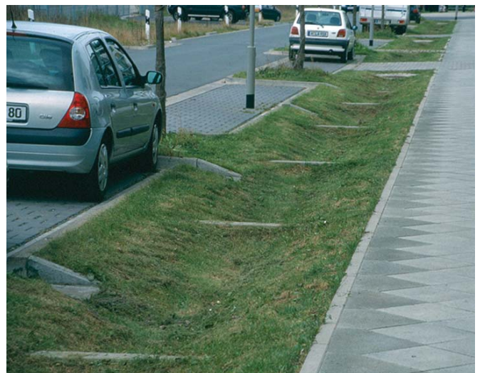
Abb. 50: Lineare Rückhaltung in straßenbegleitenden Muldenkaskaden
