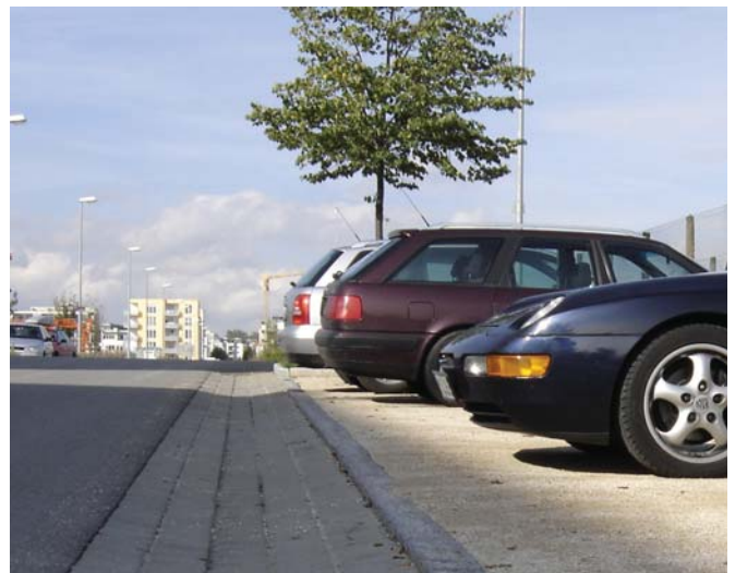
Abb. 42: Zur verkehrssicheren Planung gehört es, die Überfahrbarkeit von offenen Rinnen sicher zu stellen.
