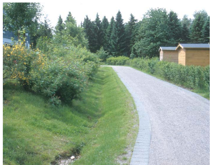
Abb. 44: Naturnahe Wegeentwässerung, breitflächig über die Schulter
