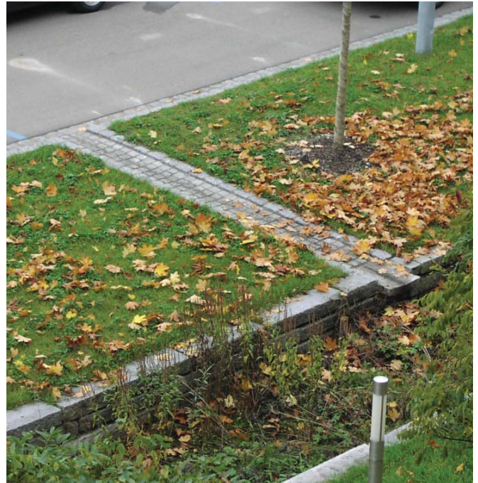
Abb. 82: Pflasterrinnen leiten das Straßenwasser in die mit Trockenmauern eingefassten Mulden-Rigolen.
