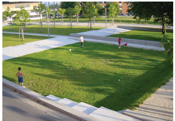
Abb. 22: Rückhaltung Offene Rückhalteflächen bieten den ökologischen Ausgleich, erzeugen große hydraulisch dämpfende Wirkung und ermöglichen darüber hinaus multifunktionale Nutzungen.
