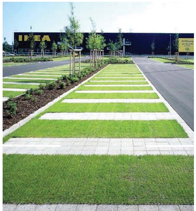
Abb. 37: Kombination von Rasengittersteinen und haufwerksporigen Steinen auf einer Stellplatzanlage
