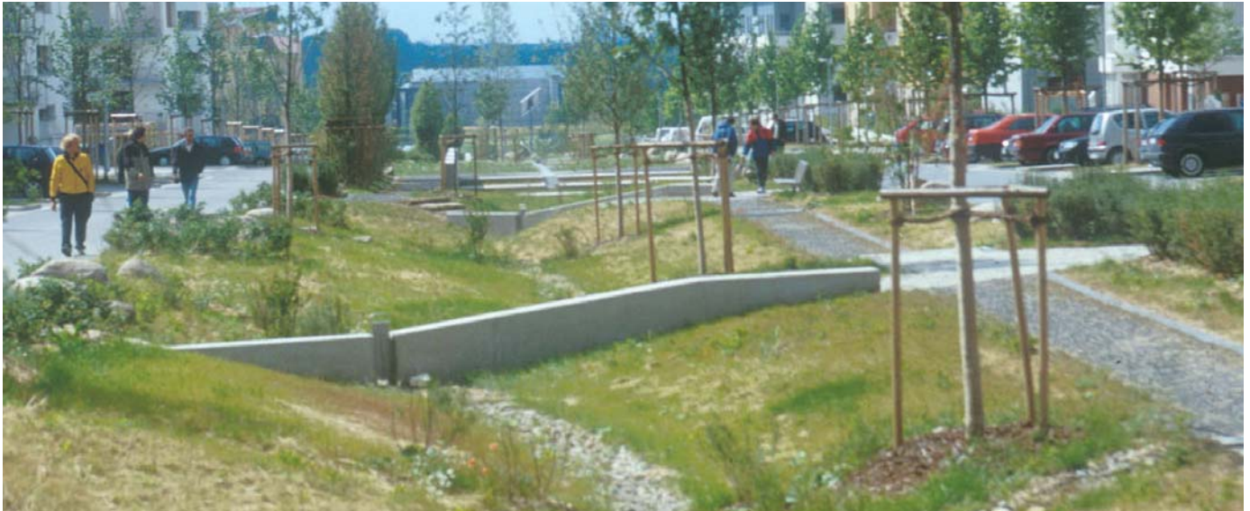
Abb. 46: Multifunktionale Gestaltung einer Allee mit Retentionskaskade
