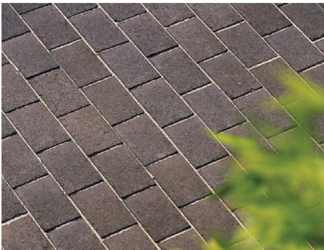
Abb. 30: Betonpflaster mit Dränfugen
