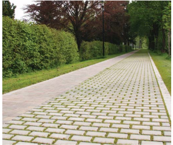
Abb. 27: Rasenfugenpflaster auf wenig befahrenem Fahrweg
