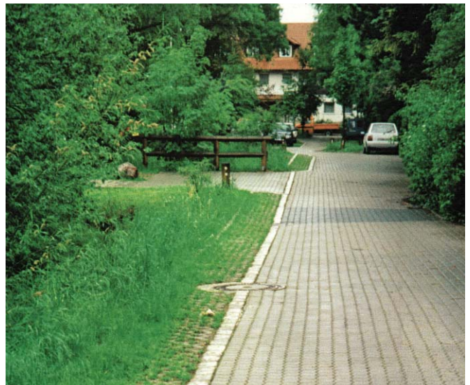
Abb. 67: Breitflächige Versickerung am Randstreifen
