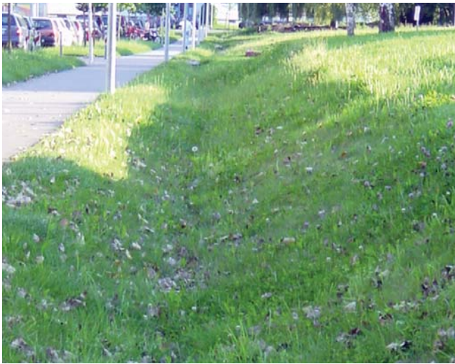
Abb. 39: Einfache Rasenmulde zur leistungsfähigen, gesammelten Ableitung mit Verdunstungsförderung
