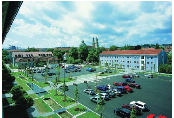
Abb. 10: Naturnahe Parkplatz- und Gebäudeentwässerung am Staatlichen Hochbauamt in Kempten
