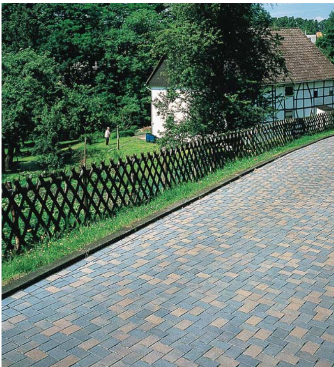
Abb. 36: Pflasterbelag mit Dränfugen auf einer Ortsdurchfahrt
