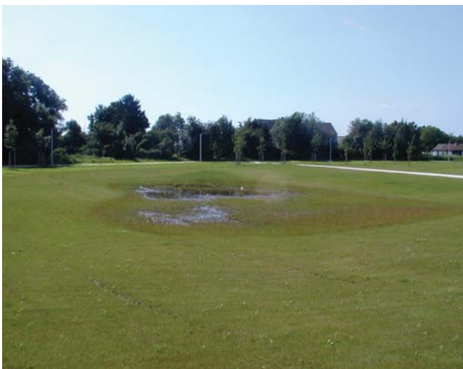
Abb. 49: Hier gibt es keine Sicherheitsbedenken - Rückhalte mulde mit temporärem Einstau in Kombination mit Versickerung.
