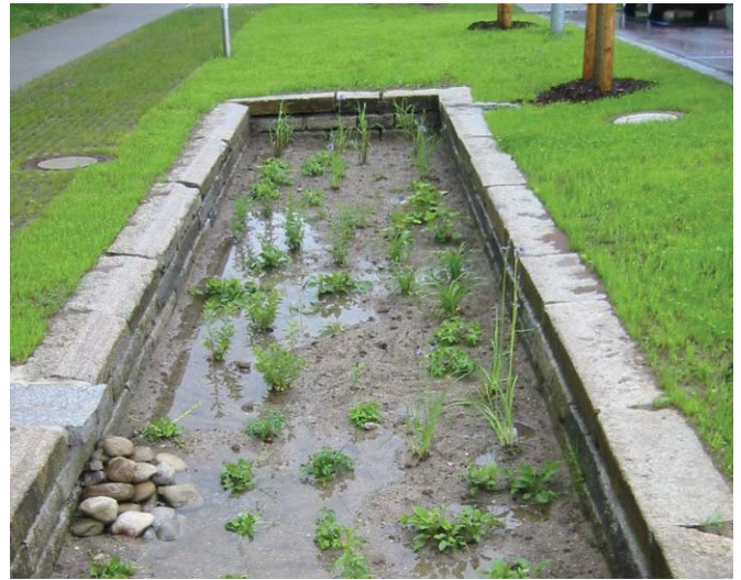
Abb. 53: Versickerung durch bewachsenen Oberboden ist auch im innerstädtischen Bereich möglich. Sie kann wie hier ein Gestaltungsthema im Freiraum sein. (im Bild: frisch bepflanzt Muldenrigolelement)
