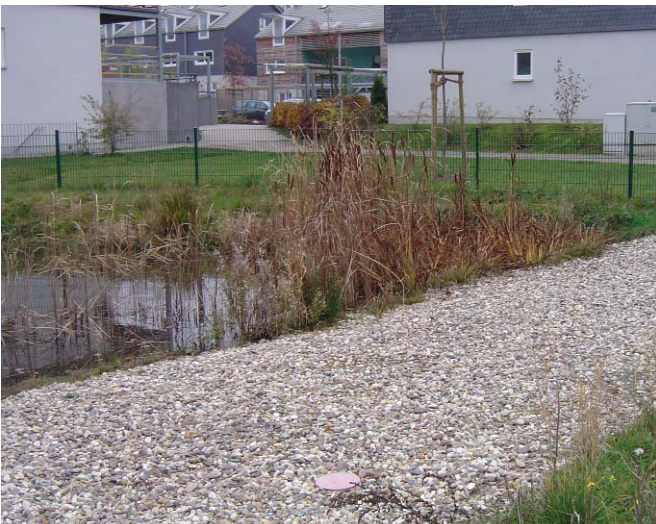
Abb. 62: Versickerungsrigole als Überlauf für den Absetzteich
