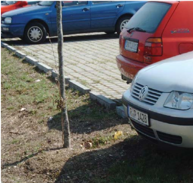
Abb. 74: Erlaubnisfreie Versickerung ist auch auf großen Parkplätzen wie an der Fachhochschule Regensburg machbar. Möchte man auf Bordsteine nicht verzichten, können als Ersatz für Straßeneinläufe und Rohrleitungen „Zahnlücken“ in Meterabständen den direkten Abfluss über die Randstreifen ermöglichen. Bau- und Unterhaltungskosten sinken so. Auf dem Fließweg über eine grasbewachsene Böschung wird das verschmutzte Wasser ausgezeichnet gereinigt (Das Bild zeigt den neu angelegten Parkplatz mit beginnender Begrünung).
