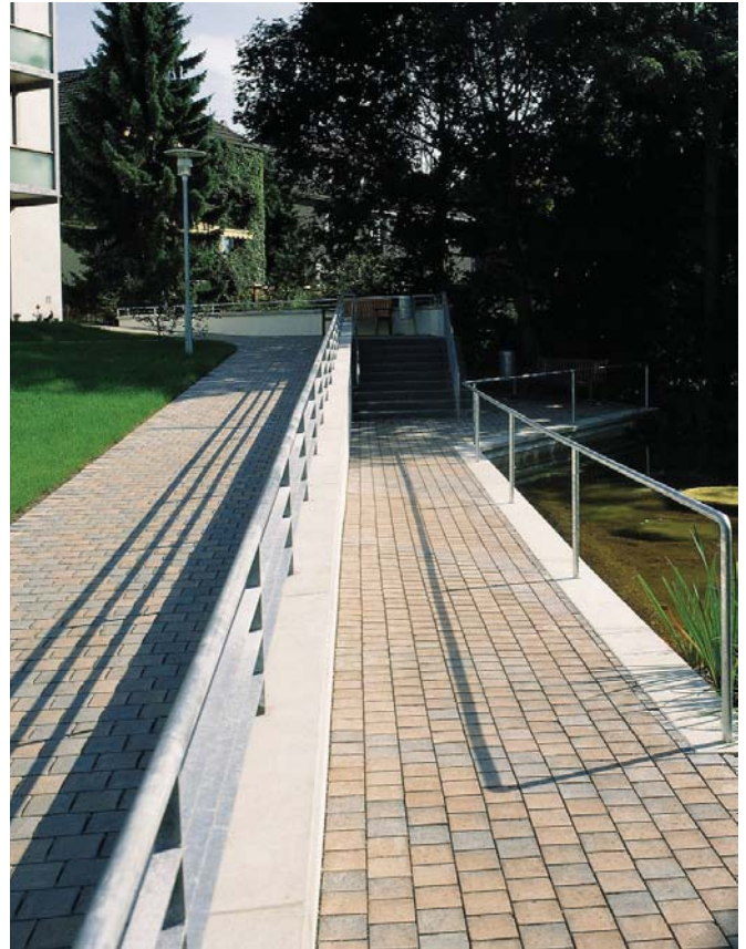
Abb. 35: Pflasterbelag mit Dränfugen auf einem Geh- und Radweg
