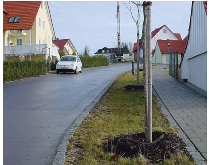
Abb. 75: Erlaubnisfreie Versickerung in Neubaugebieten im ländlichen Bereich ist häufig kein Problem - hier in Ilmmünster fließt das Wasser ungesammelt über den Straßenrand in den Grünstreifen und versickert über den bewachsenen Oberboden.
