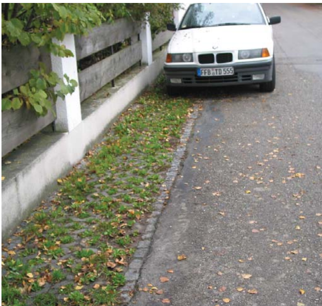
Abb. 77: Ein etwa 50 Zentimeter breiter Streifen an den Straßenrändern reicht bei durchlässigem Untergrund zum Versickern vollkommen aus. Der Oberboden filtert die meisten Schadstoffe hervorragend heraus und das Gras sorgt dafür, dass der gesammelte Schmutz immer wieder durchwurzelt wird, so dass die Versickerungsfähigkeit auf Dauer sichergestellt ist. Ist damit zu rechnen, dass dieser Streifen von Autos zum Parken befahren wird, sollte er mit Rasengittersteinen befestigt werden, um seine Versickerungsleistung auf Dauer zu erhalten.
