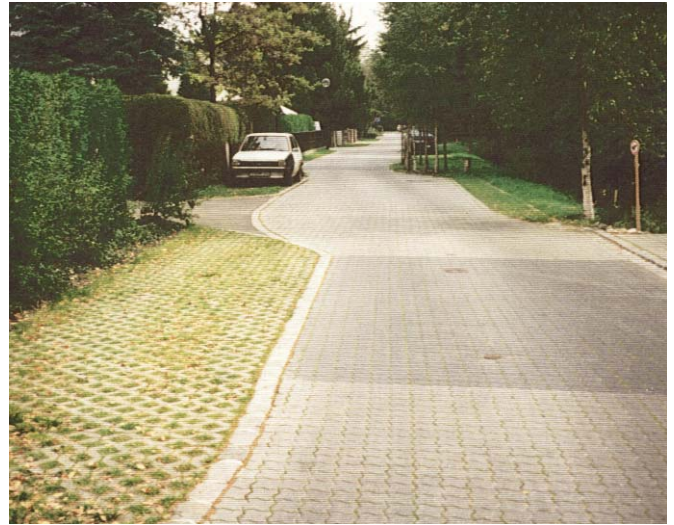
Abb. 61: Versickerung durch Pflaster mit offenen Fugen und auf grasbewachsenen Stellplätzen
