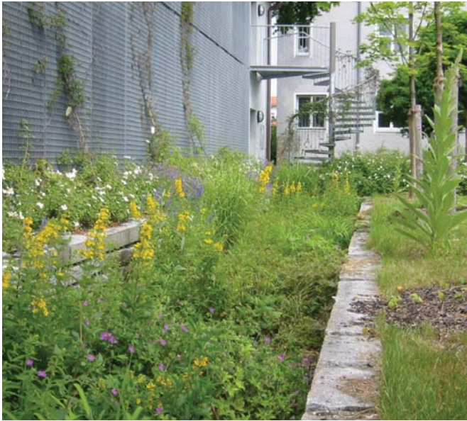
Abb. 81: Mulden-Rigolen mit Staudenbewuchs im 5. Standjahr. Damit bleibt der bewachsene Oberboden dauerhaft durchlässig. Zwei Pflegedurchgänge mit Abmähen und Auflockern werden hier im Jahr durchgeführt.
