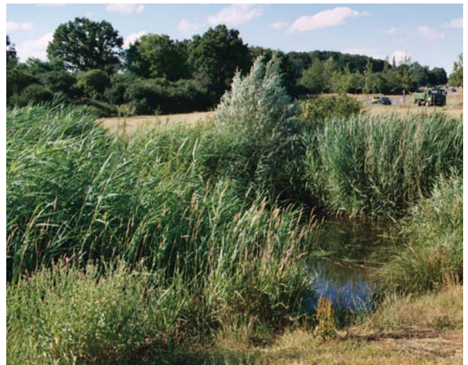
Abb. 55: Naturnah gestalteter Regenklär- und Absetzteich zur Straßenwasserreinigung
