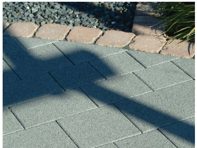
Abb. 31: Betonpflaster aus haufwerksporigem Beton
