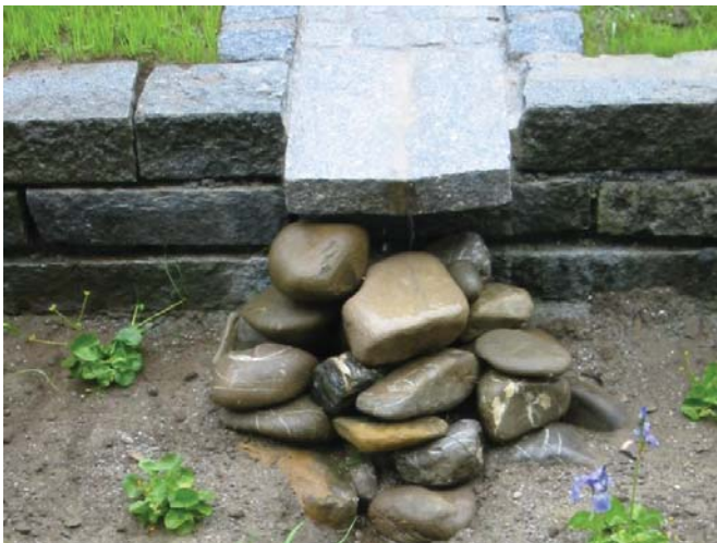
Abb. 84: Gestaltete Rinneneinleitung in das Muldenrigolenelement
