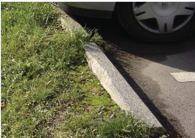
Abb. 21: Entwässerung durch Lücken im Bordstein. Reinigung über den bewachsenen Oberboden. Die langjährige Reinigungswirkung ist durch Untersuchungen belegt [4] [5]. Der Bewuchs sichert die Versickerungsfähigkeit auf Dauer.
