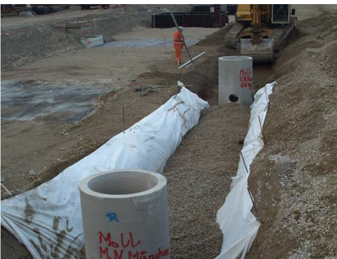
Abb. 64: Die unterirdische Versickerung wird vielfach verwendet, weil sie sehr platzsparend ist. Das beliebte Vlies seitlich und unter Rigolen ist jedoch nicht nur überflüssig, sondern auch riskant (siehe Abb. 65).
