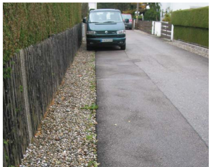
Abb. 78: Das Grundwasser ist nicht ausreichend geschützt, wenn das mit Schadstoffen belastete Straßenwasser lediglich durch einen Streifen Rollkies versickert. Der Kies ist nicht in der Lage, Öl, Benzin oder Schwermetalle herauszufiltern. Diese Stoffe gelangen ungehindert in das Grundwasser, vor allem, wenn es hoch steht. Bewachsener Oberboden ist eine zwingende Voraussetzung für das flächenhafte Versickern.
