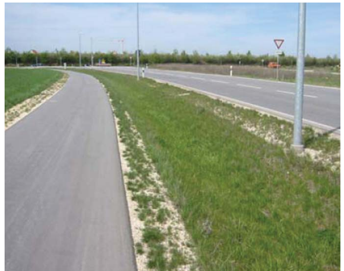
Abb. 76: Eine erlaubnisfreie Versickerung an Kreisstraßen ist nicht ausgeschlossen, wenn wie hier in Neutraubling, das Oberflächenwasser ungesammelt über den Straßenrand in die Straßenmulde fließt und dort versickern kann.
