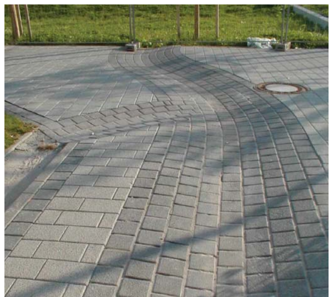
Abb. 73: Offene Ableitungsrinnen in Wohnstraßen, wie in der Siedlung "Am Rosensee" in Aschaffenburg, sind kostengünstiger als Kanäle. Sie fördern die Verdunstung, ermöglichen Gestaltungsvielfalt und machen Regenwasser wieder erlebbar. Langjährige Erfahrungen haben gezeigt, dass offene Rinnen auch im Winter keine Probleme mit sich bringen.
