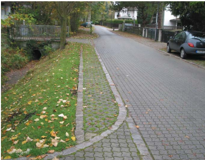
Abb. 70: Führt eine Straße an einem Bach entlang, so kann der Niederschlag in der Regel ohne eine Erlaubnis eingeleitet werden. Vorbildlich geschieht dies, wie hier in Gröbenzell, wenn das Wasser direkt über die Schultern der Straße in den Bach fließen kann.
