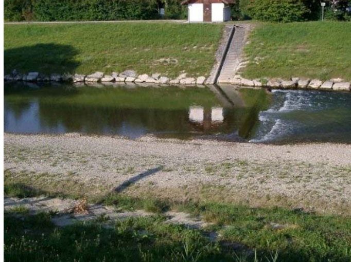
Abb. 3.13 Pegel Weilheim/Ammer im Sommer 2003: Geringe Wassermengen fließen über die Schwelle am Pegel, im Vordergrund ist das freiliegende Kiesbett zu sehen.
